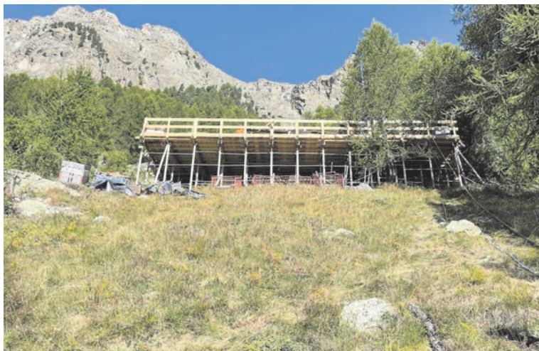
Die temporäre Plattform im unwegsamen Gelände.
