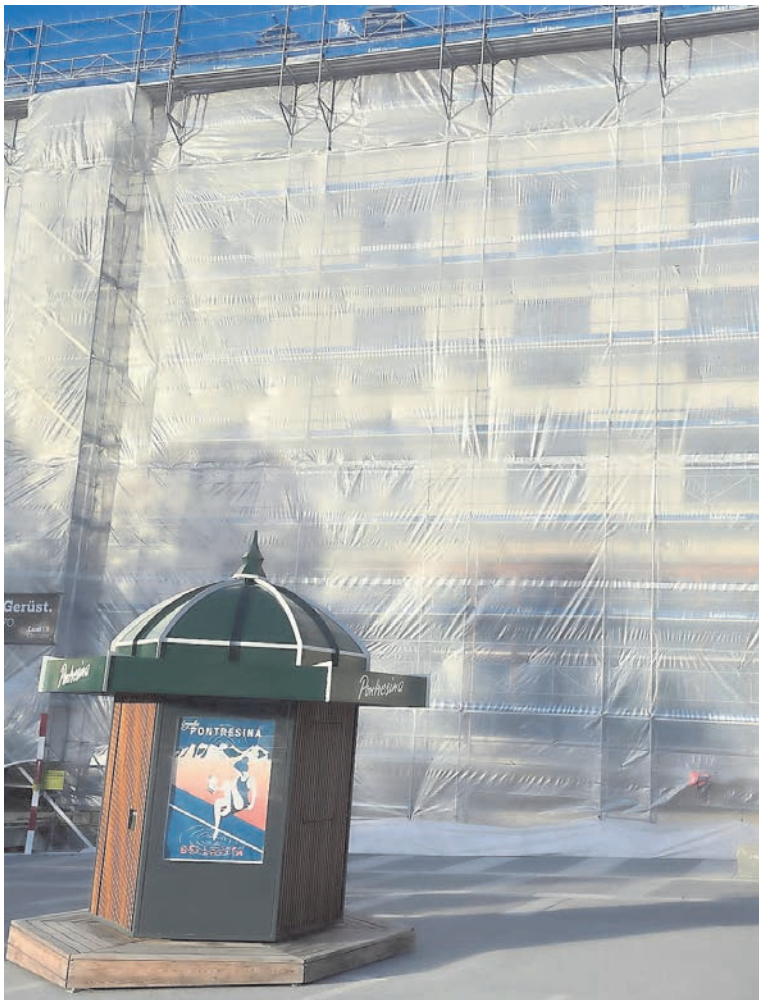
In Pontresina ist neu nicht mehr der Gemeindevorstand für die Bewilligung von Baugesuchen zuständig, sondern die Baukommission. Foto: Reto Stifel
