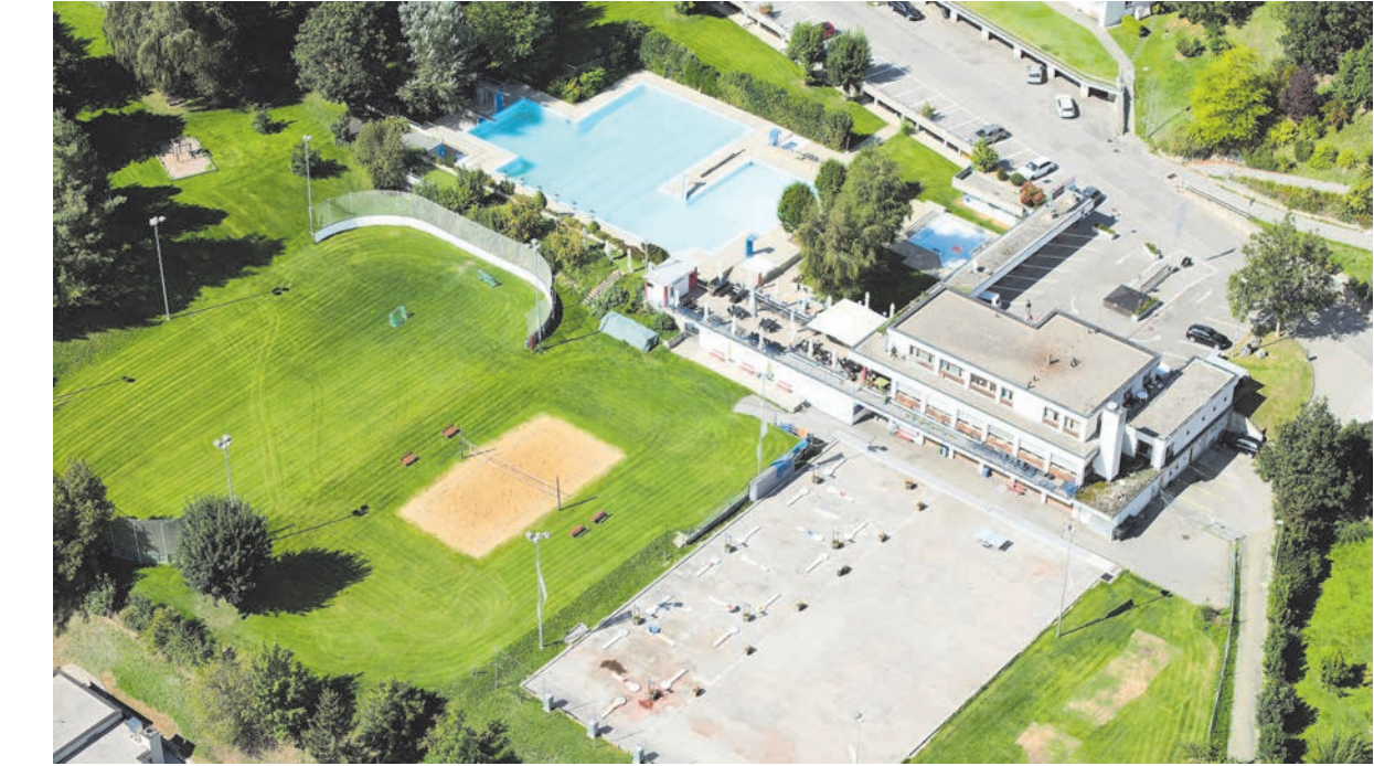
La platta da beton i'l bogn avert Trü es decadenta. Perquai es l'infrastructura da sfradar e s-chodar gnüda tutta our d'funcziun.
