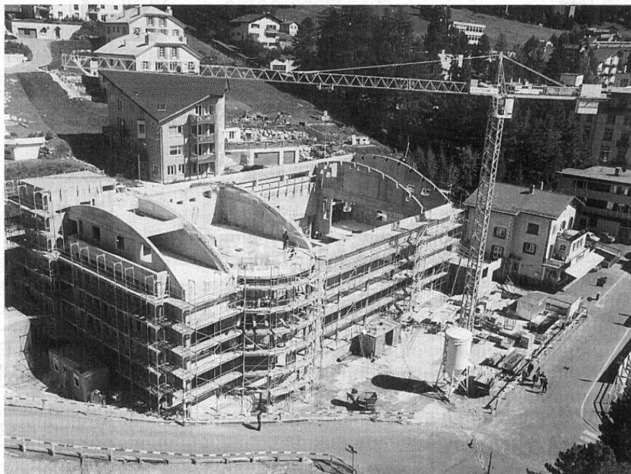
Gegenwärtig in der Rohbauvollendung: das Pontresiner Kongress-, Informations- und Kulturzentrum «Rondo».
