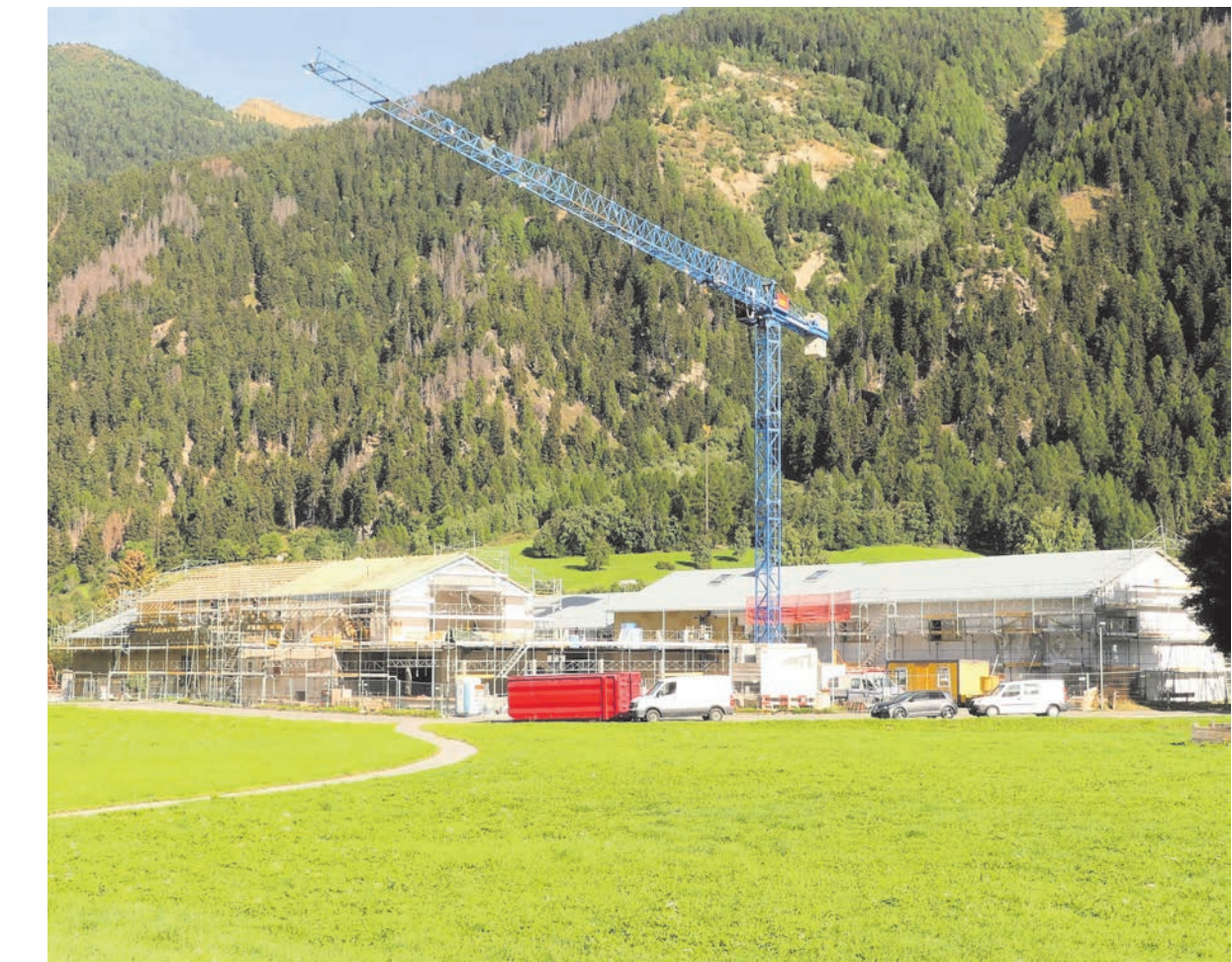
In schner da quist on han cumanzà las lavuors da sanaziun e modernisaziun.
