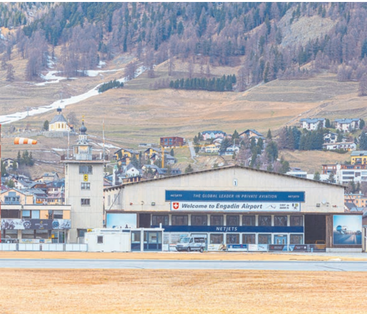
In den kommenden Jahren sollen die Hochbauten und weitere betriebliche Anlagen erneuert werden. Archivfoto: Daniel Zaugg
