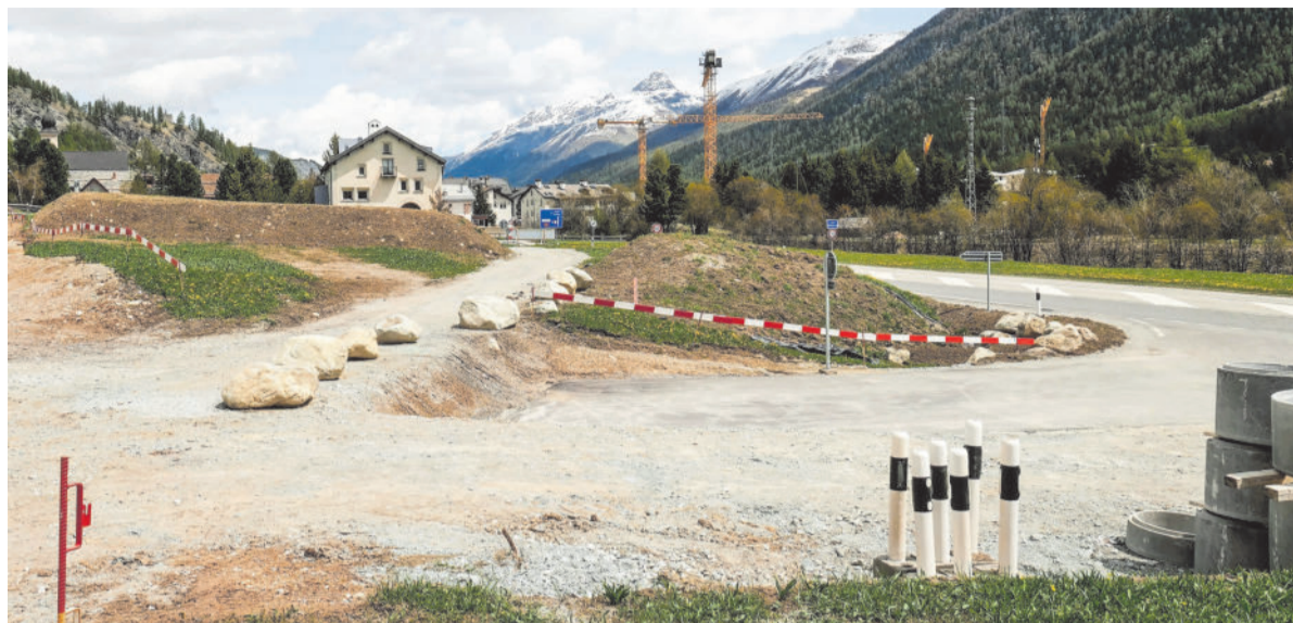
Das Baustellenportal «La Punt Süd» wird später reaktiviert als vorgesehen.
