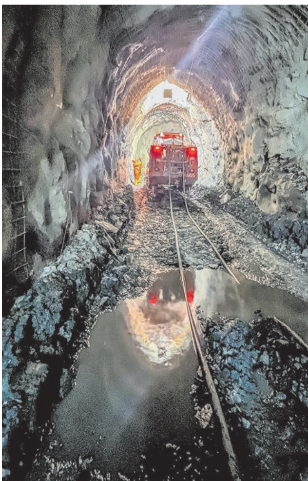
Von links: Im Ostarm des Entwässerungstollens sind aktuell rund 650 von vorgesehenen 764 Metern Sprengvortrieb erfolgt. In solchen Bohrnischen werden weiter hinten vertikale Sondierungs- und Drainagebohrungen bis in die Rutschmasse ausgeführt. Das so abgeleitete Wasser wird gefasst und in die Albula geführt. TBA-Projektleiter Josef Kurath gibt Medien Auskunft und demonstriert die Wirksamkeit der Bohrungen.
