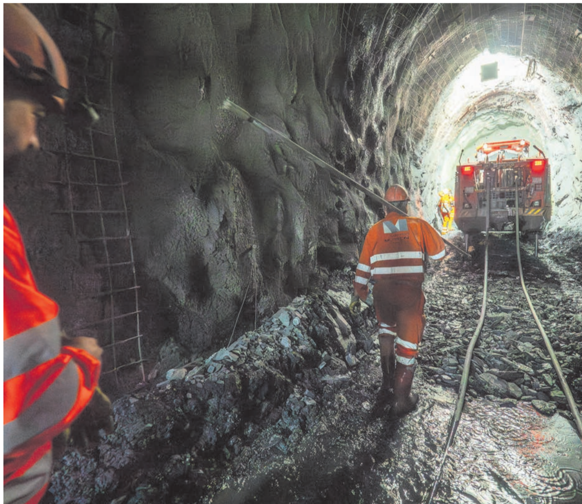
Seit September 2021 sind die Bauarbeiten für den Entwässerungstollen unterhalb von Brienz/Brinzauls im Gange. Während hier der Stollenvortrieb erfolgt, werden weiter hinten Drainagelöcher in den Berg gebohrt. Foto: Jon Duschletta
