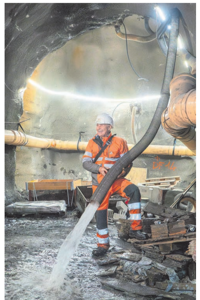
Von links: Im Ostarm des Entwässerungstollens sind aktuell rund 650 von vorgesehenen 764 Metern Sprengvortrieb erfolgt. In solchen Bohrnischen werden weiter hinten vertikale Sondierungs- und Drainagebohrungen bis in die Rutschmasse ausgeführt. Das so abgeleitete Wasser wird gefasst und in die Albula geführt. TBA-Projektleiter Josef Kurath gibt Medien Auskunft und demonstriert die Wirksamkeit der Bohrungen.
