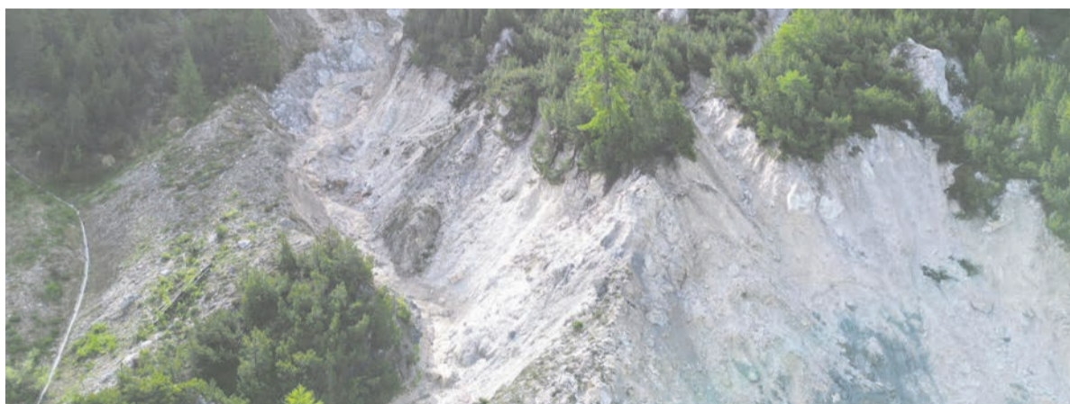
Der Abbruch oberhalb Sta. Maria in Richtung Umbrailpass, «il S-charp da Schais», ist vom Dorf aus gut sichtbar.
