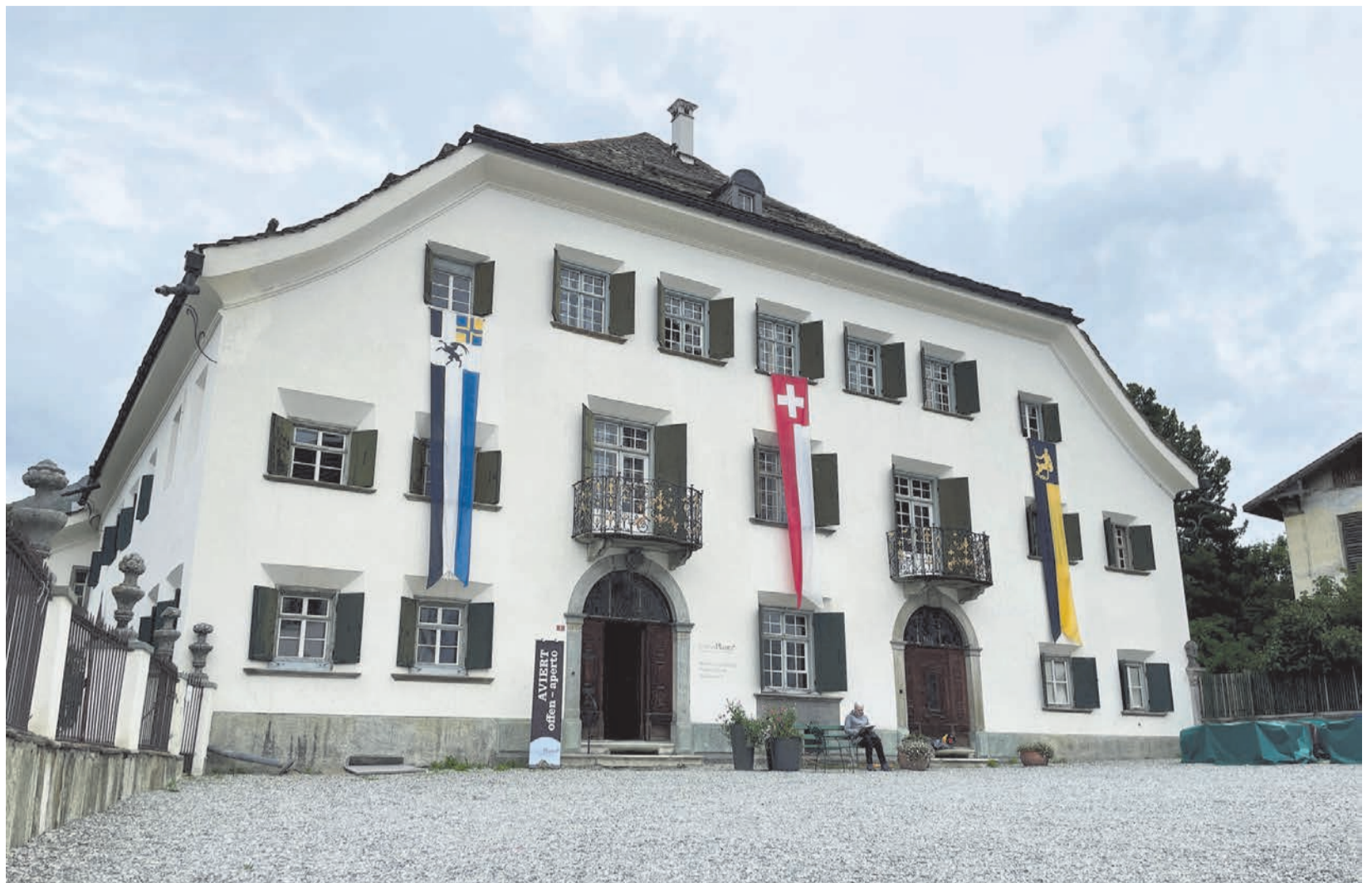
In der Chesa Planta Samedan kommt es vor allem in den Kellerräumen zu Problemen mit hoher Feuchtigkeit und Radonbelastung.
