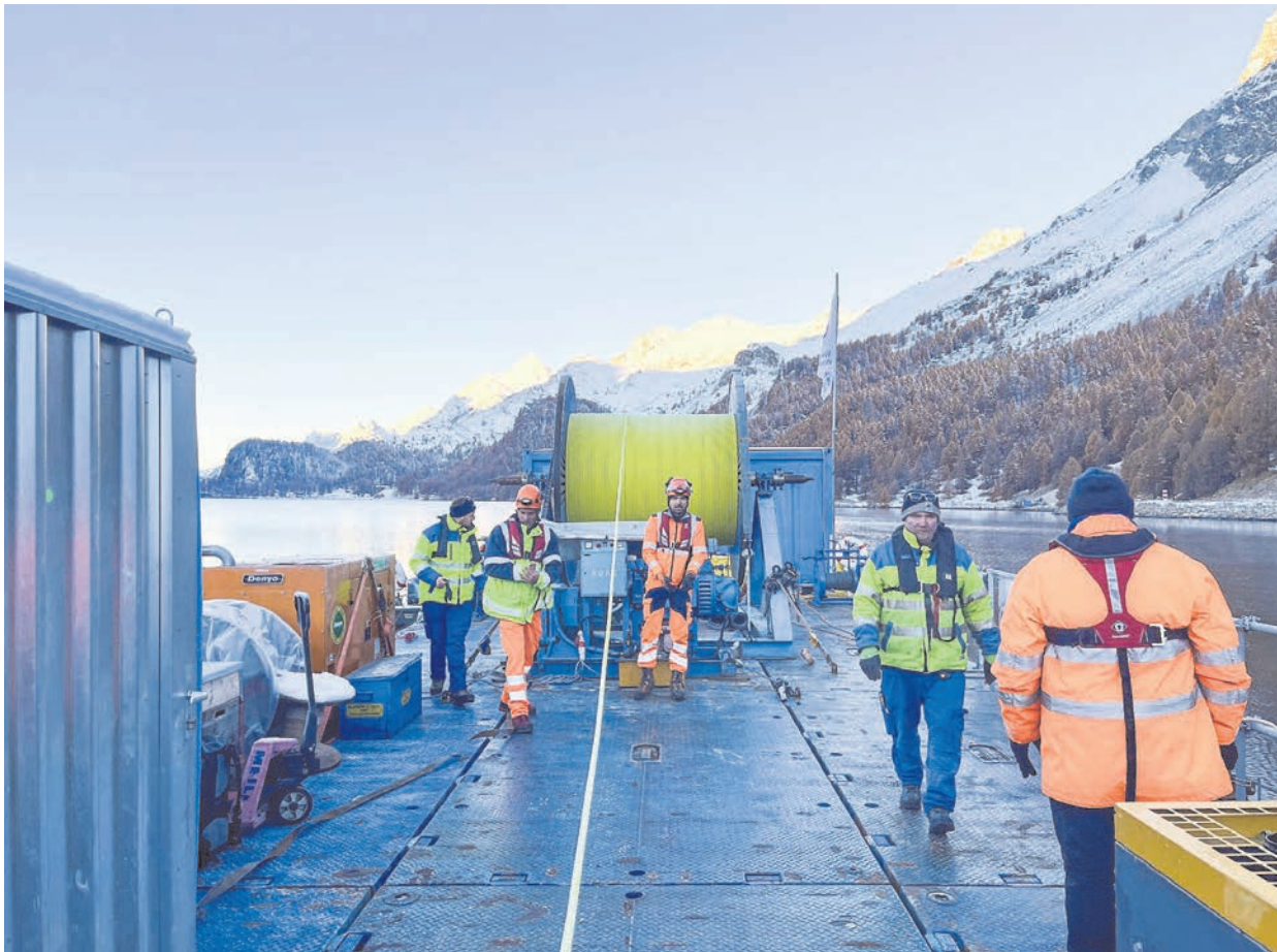
Das Kabel wird von der Bobine durch ein «Leitgerät» geführt. Dieses misst die exakte Abwickelgeschwindigkeit, mit welcher das Glasfaserkabel im See versinkt und schliesslich wieder an Land kommt.
