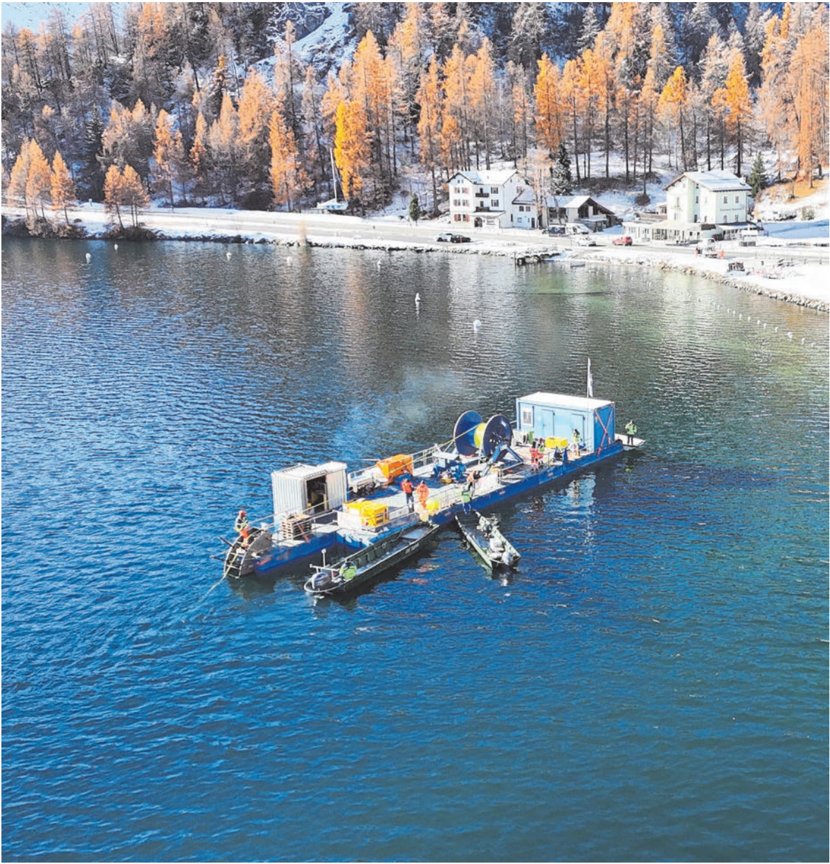
Das Ziel ist erreicht. In Plaun da Lej wird der Rest des Kabels von der Bobine abgerollt und an Land gezogen.
