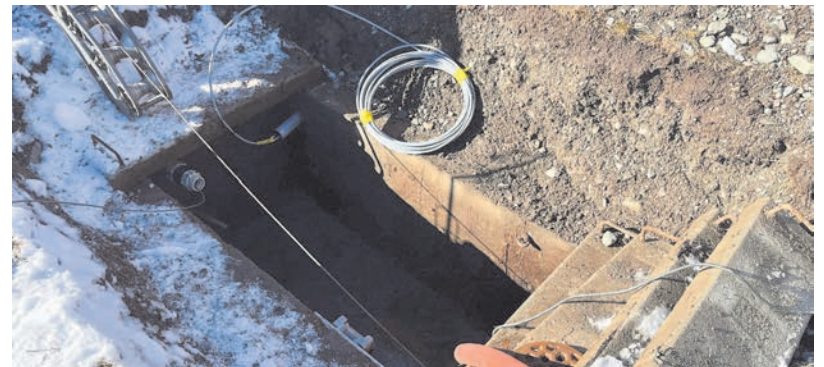
Das Kabel wird von der Bobine durch ein «Leitgerät» geführt. Dieses misst die exakte Abwickelgeschwindigkeit, mit welcher das Glasfaserkabel im See versinkt und schliesslich wieder an Land kommt.
