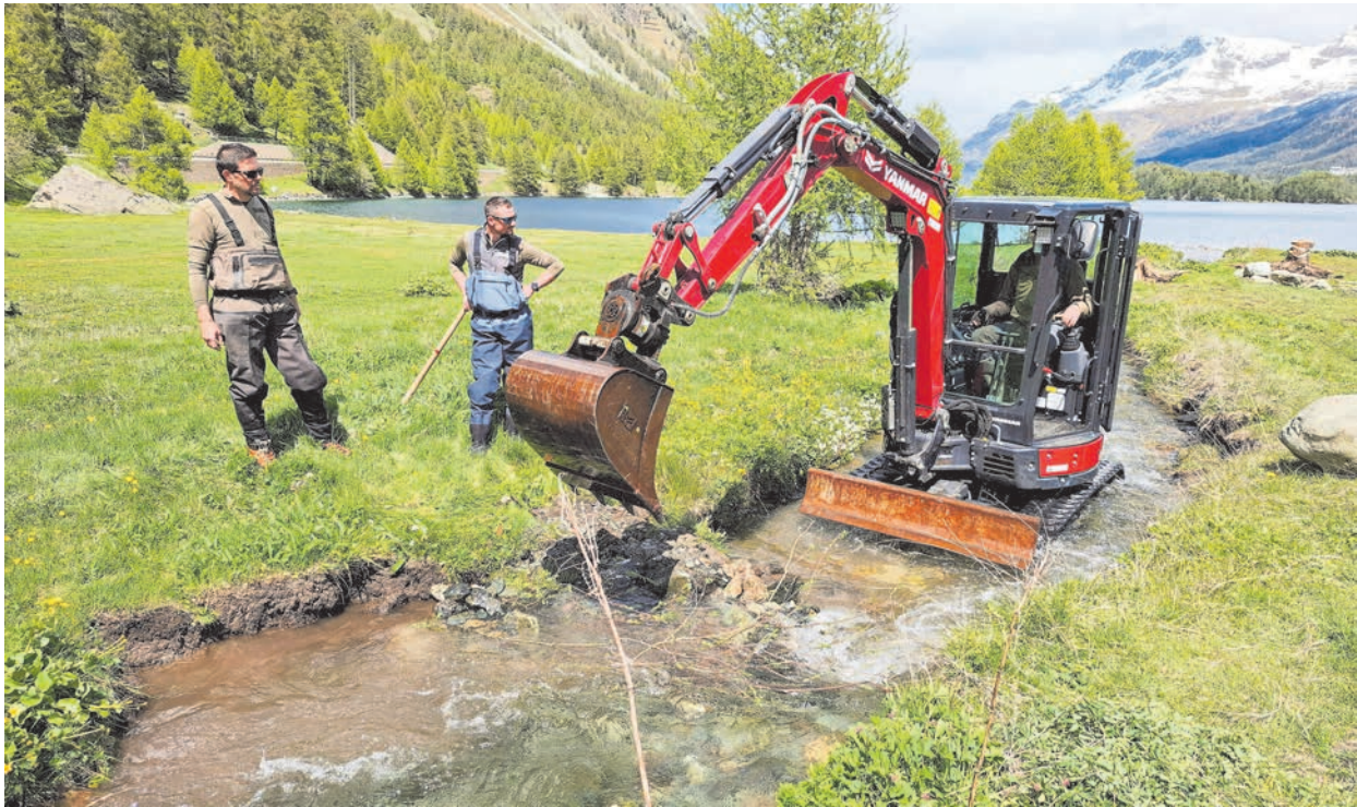
Um die grössten Eingriffe im Bachbett und an den Ufern des Baches vorzunehmen, wurde ein kleiner Raupenbagger benötigt. Nur schon ein Wurzelstock kann die Struktur eines Gewässers aus ökologischer Sicht positiv verändern. Fotos: Amt für Jagd und Fischerei
