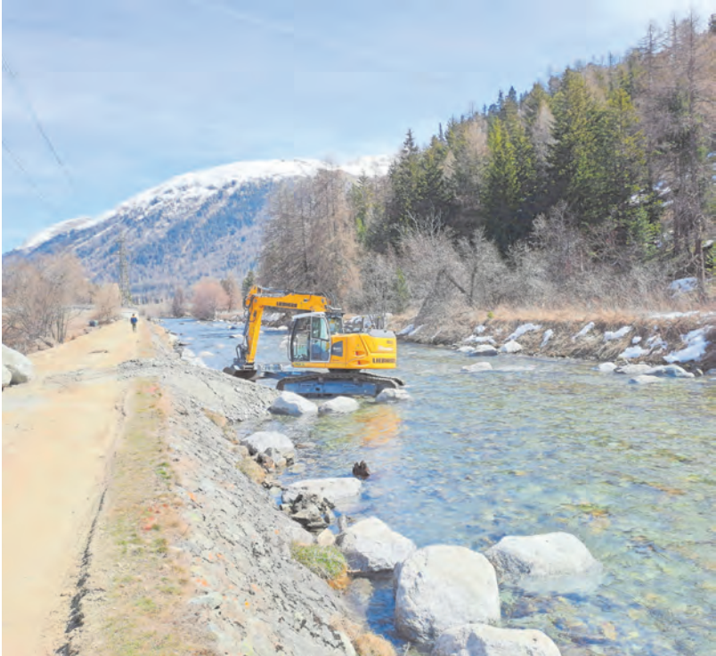
Die Strukturblöcke werden im Gerinne verlegt. Diese ändern die Gewässerdynamik und bieten Schutz.
