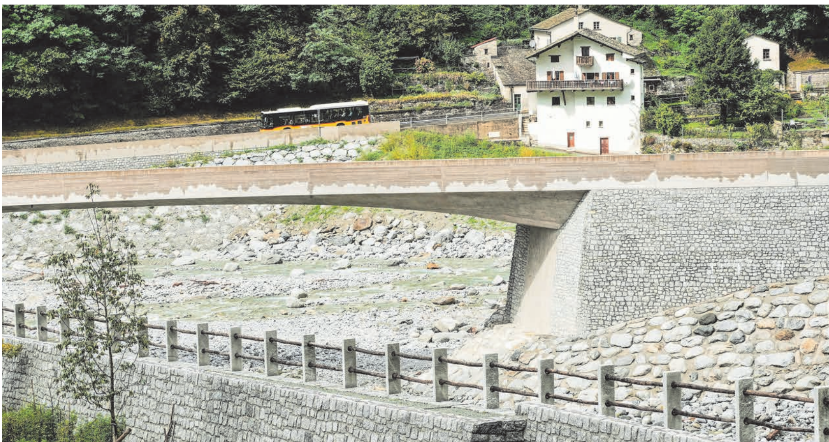
Blick von Bondo in Richtung Sottoponte und der neuen, um über fünf Meter erhöhten Kantonsstrassenbrücke Bondasca (Bildmitte) über dem Zusammenfluss von Maira und Bondasca sowie dem neuen Dammweg entlang des Rückhaltebeckens im Vordergrund. Foto: Jon Duschletta
