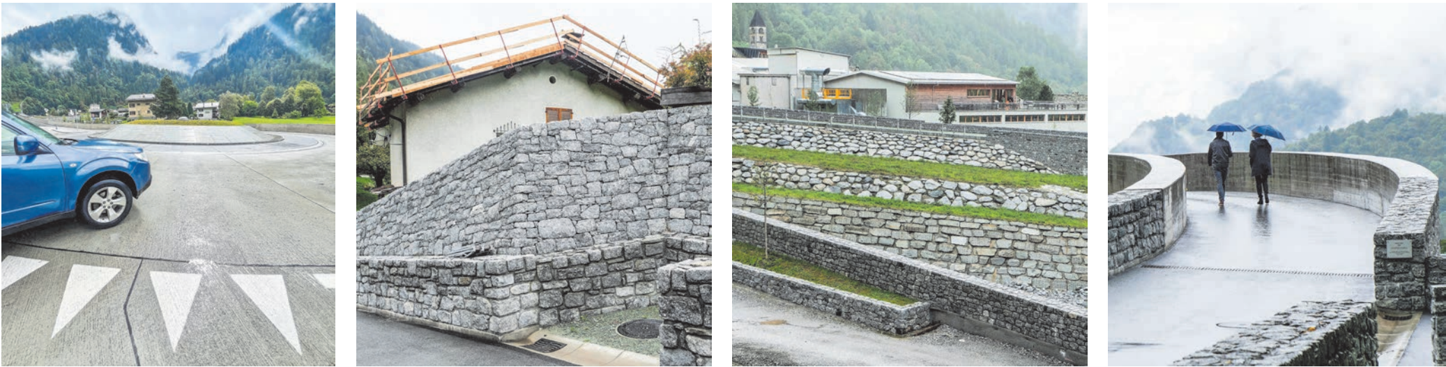
Von links: Ein Kreisel an der Kantonsstrasse sorgt für mehr Sicherheit, während Schutzmauern im Gefahrenbereich die Häuser vor weiterem Unheil schützen sollen. So auch die nach dem Murgang neu gebaute Schreinerei der Bruno Clalüna AG. Die neue Brücke «Punt» als Verbindung zwischen den Fraktionen Bondo und Promontogno. Fotos: Jon Duschletta
