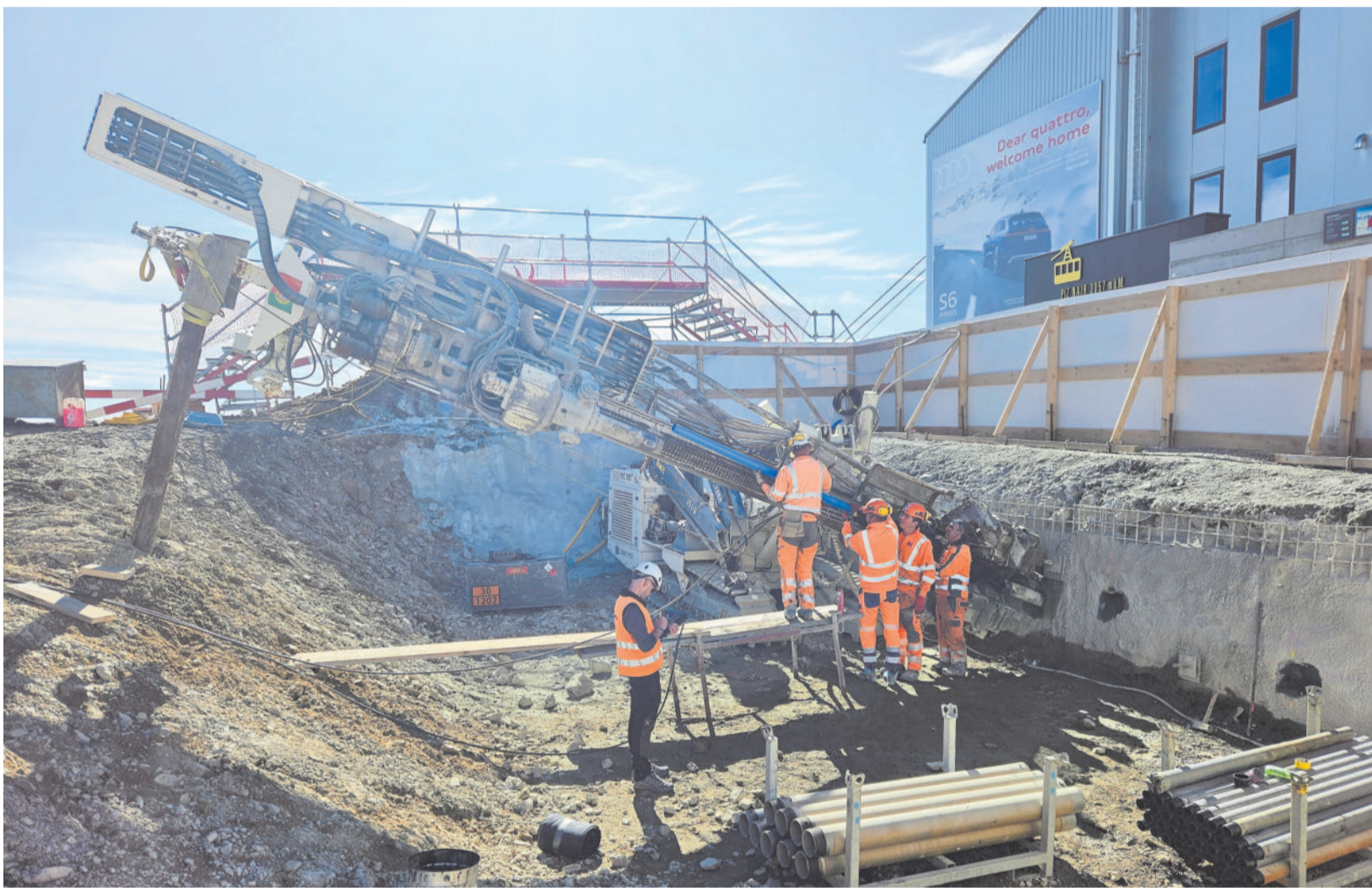
Bohrarbeiten auf der Bergstation Piz Nair sind eine logistische Herausforderung, die auch viel Erfahrung von den Bauarbeitern verlangt. Foto: Thomas Brunner
