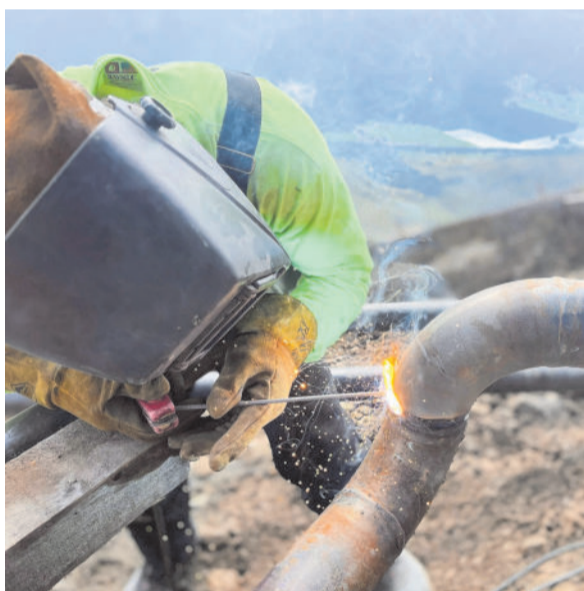
Exaktes Arbeiten ist gefragt. Spezialisten, die aus Amerika angereist sind, schweissen die Kühlrohre zusammen. Thomas Brunner (Mitte) in der Besprechung für die nächsten Schritte.
