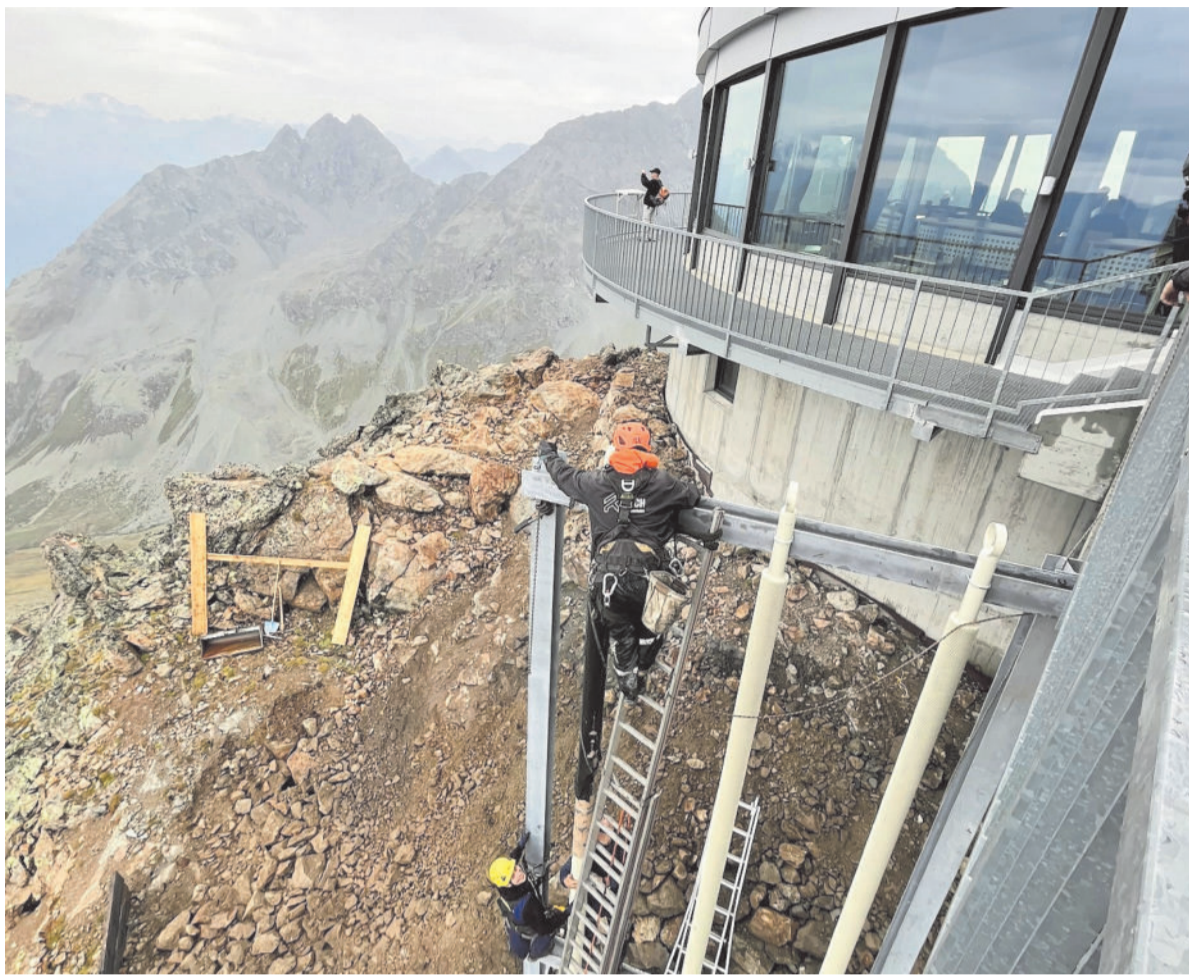
Die Montage der Kondensatoren in luftiger Höhe erfordert Schwindelfreiheit.
