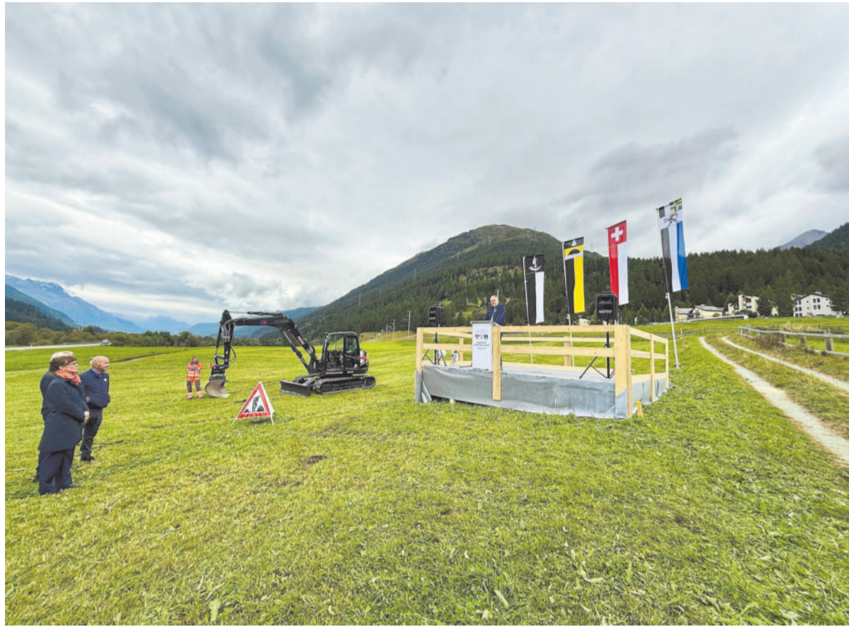
Mit Podest und Bagger wurde der Spatenstich für die Umfahrung in La Punt gefeiert, im Bild Kantonsingenieur Reto Knuchel.
