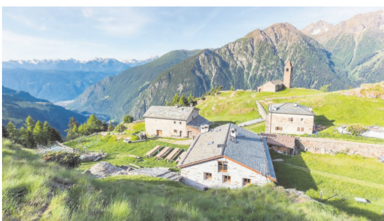
Vorbehaltlich einer gesicherten Restfinanzierung unterstützt der Kanton das Sanierungsprojekt «Rifugio Alpe San Romerio».
