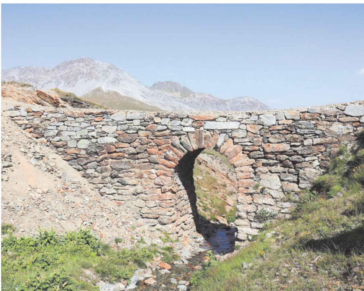
La via militar cun tuot las serpentinas es fingià gnüda fabrichada dal 1911, causa cha l'armada svizra spettaiva bod o tard in quista regiun üna confrontaziun militar tanter l'Austria e l'Italia. A schnestra La punt fabrichada cun mürs sechs chi maina sur il flüm Muranzina.
