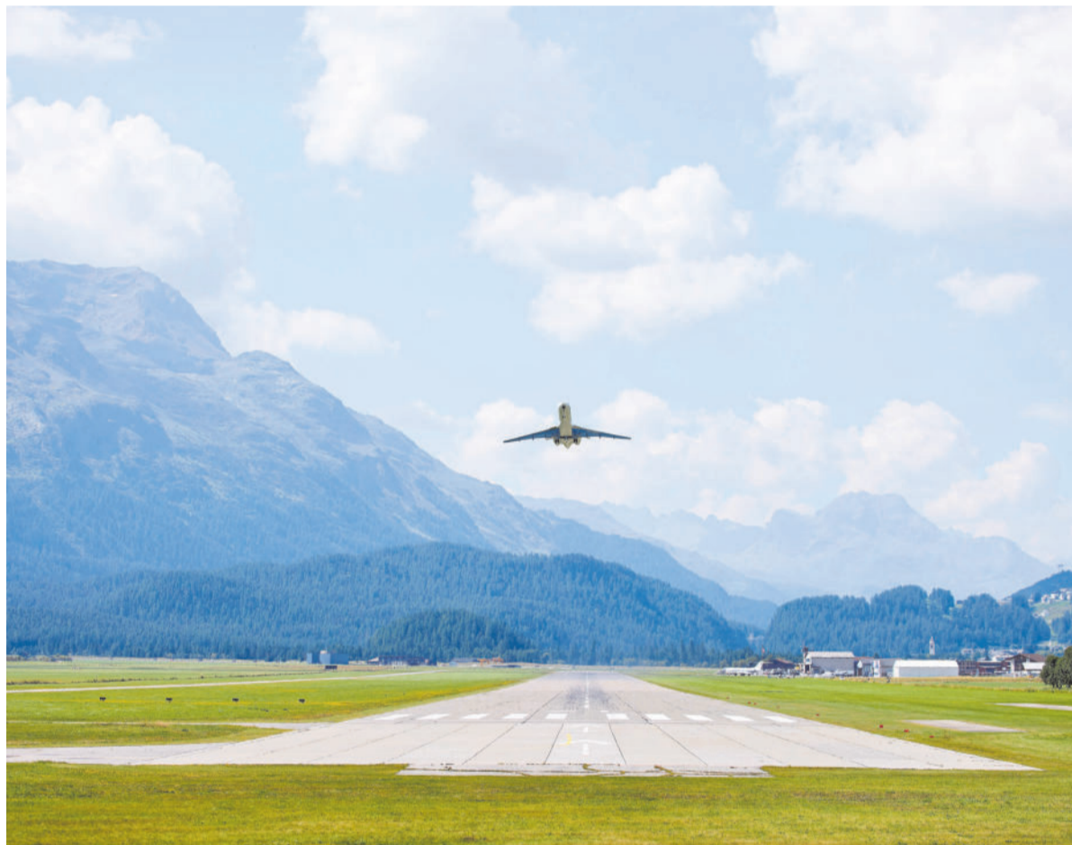
Wann kann der Baustart zu den Erneuerungsarbeiten am Flughafen erfolgen? Die Antwort auf diese Frage hängt von verschiedenen Faktoren ab. Foto: FMR/Michael Steiner
