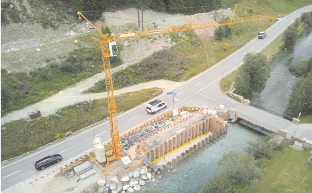
Der neue Fischaufstieg ist näher am Tosbecken als der alte Aufstieg, der sich auf der anderen Seite der Brücke befand. Die Baustelle stellt eine besondere Herausforderung dar.
