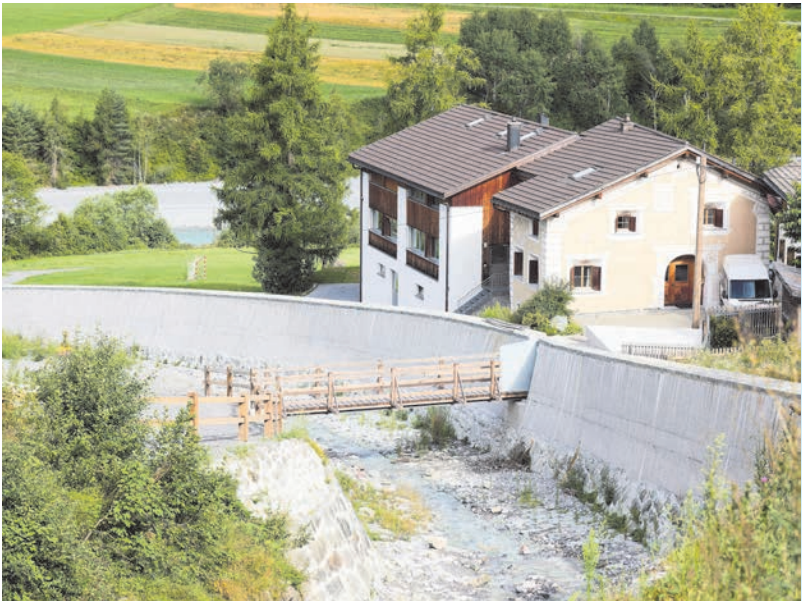
«Cun quellas massas chi sun gnüdas nu's vaiva fat quint», disch Hans Andersag, cumandant dals Pumpiers Pisoc. La nouva punt da lain a Pradella es construida uschea ch'in cas d'üna bouda gniss ella dozada oura e strat cun sai intant cha la porta d'atschal as serress per proteger il cumün. fotografias: Michael Steiner
