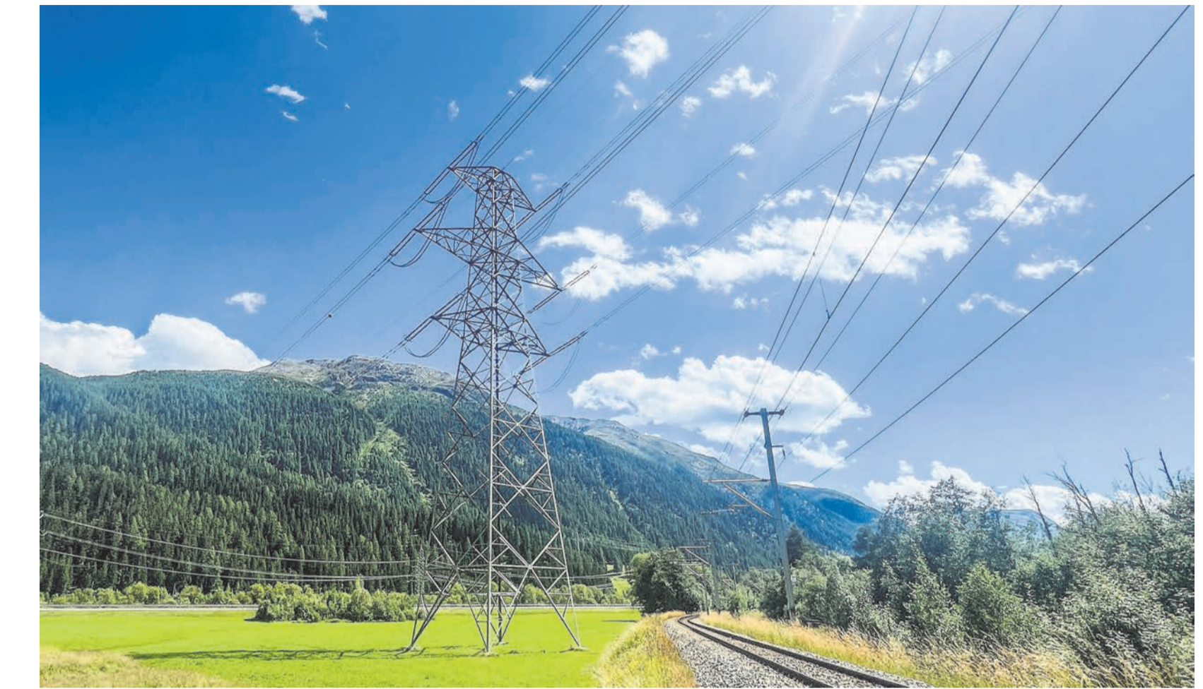
Der Mast Nr. 128 der 380-kV-Albulaleitung im Gebiet Las Agnas zwischen La Punt und Bever muss im Zuge der Leitungserneuerung und auch des Projekts der Inn-Revitalisierung ersetzt und versetzt werden. Eine unterirdische Lösung ist laut Swissgrid aber keine Option. Foto: Jon Duschletta
