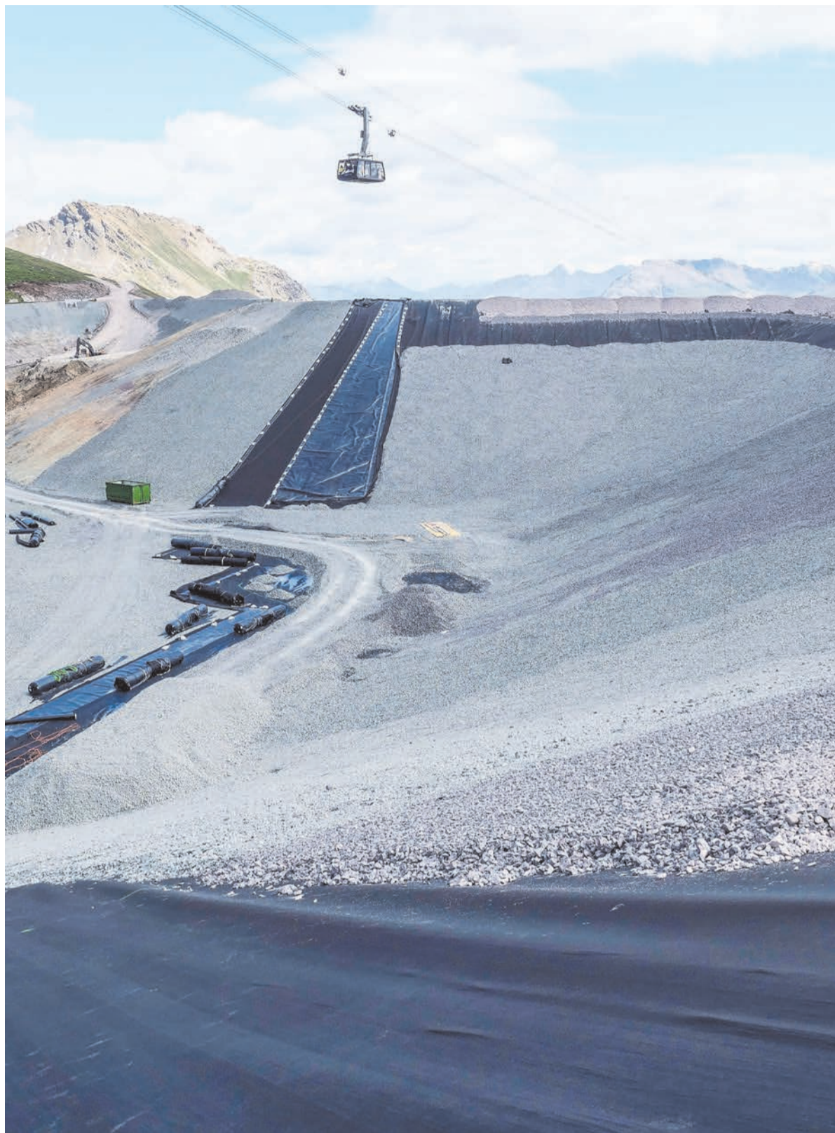
Rund 15 Millionen Franken kostet der Bau des Naturspeichersees Lej Nair Pitschen mit seinem Fassungsvermögen von gut 300 000 Kubikmetern Schmelzwasser. Das entspricht rund 1,2 Millionen Badewannen. Fotos: Jon Duschletta
