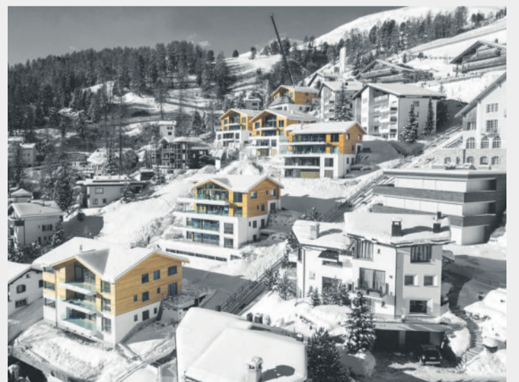
Neubau von 6 Mehrfamilienhäuser in St. Moritz, realisiert zwischen 2016 und 2019.
