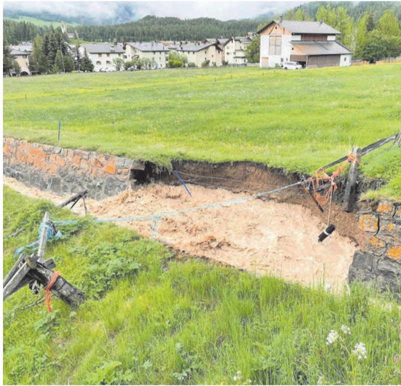
Die Wassermassen haben einen Teil des Damms mitgerissen, und die neu erstellte Brücke drohte einzustürzen und musste gesichert werden. Fotos: Corsin Taisch
