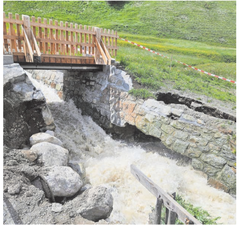
Die Wassermassen haben einen Teil des Damms mitgerissen, und die neu erstellte Brücke drohte einzustürzen und musste gesichert werden. Fotos: Corsin Taisch
