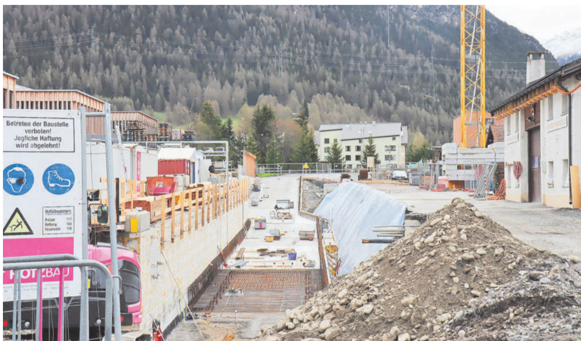
Las lavuors da fabrica vi d'ün tunnel d'access, chi collia la futura garascha da l'InnHub cun la via a La Punt, haun eir già cumanzo.
