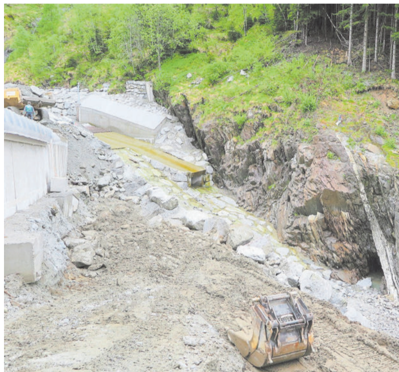
Links die alte Wasserfassung, aufgenommen vor dem Bergsturz von 2017. Rechts: Blick auf die neue Wasserfassung und die laufenden Umgebungsarbeiten. Die neue Wasserfassung ist seit Mai in Betrieb. Der Bereich neben der Wasserfassung wird zugeschüttet.
