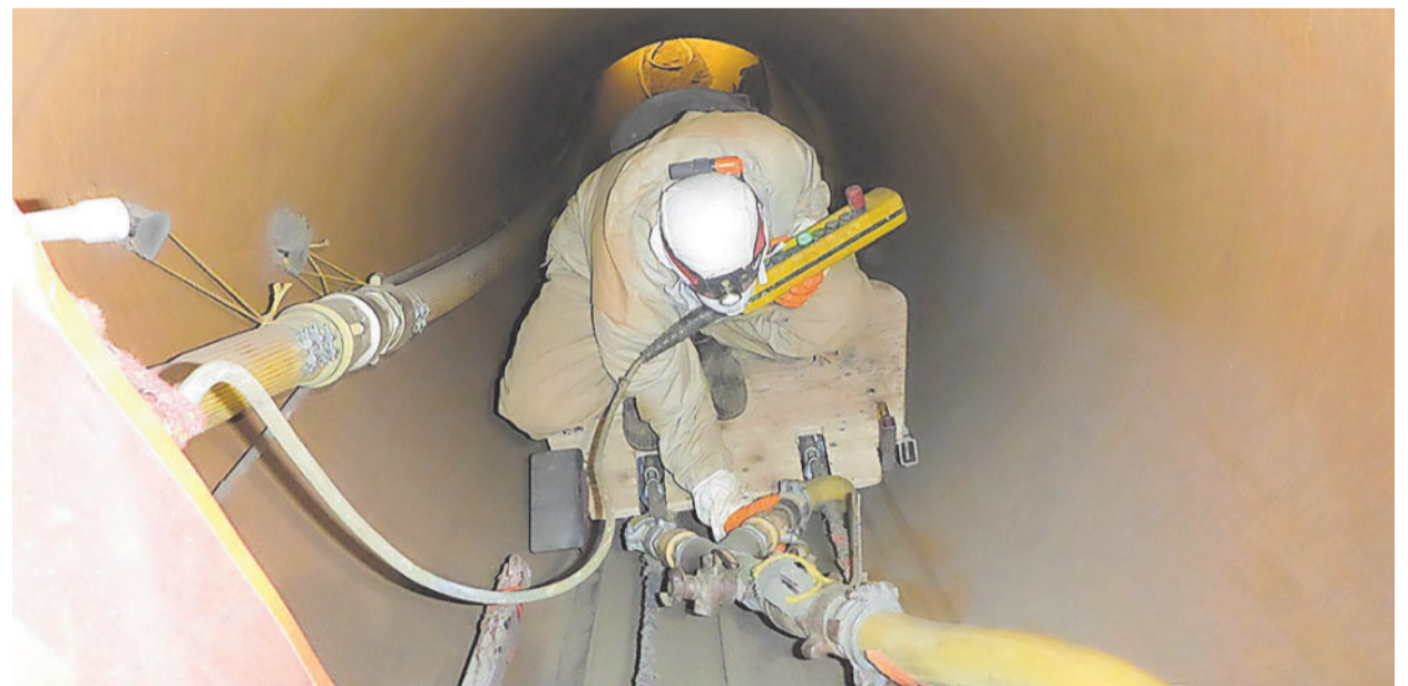
Nach acht Jahren Stillstand musste der Generator des Kraftwerks revidiert werden. Der Verantwortliche der Kraftwerke der EWZ im Bergell, Andres Fasciati (oben rechts), erklärte den Anwesenden die durchgeführten Sanierungsarbeiten der bis zu 60 Jahre alten maschinellen Anlagen. Unten rechts: Die Korrosionsschutz-Arbeiten im Inneren der Druckleitung.
