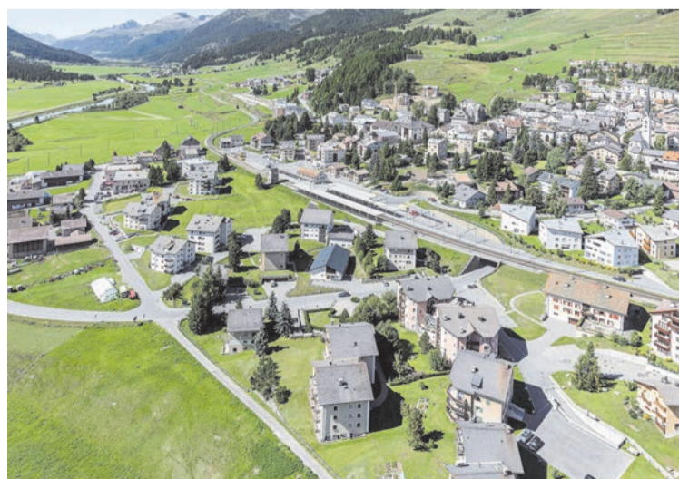
Visualisaziun da la nouva staziun da Zuoz renovada cun las novas suostas. visualisaziun: Viafier retica
