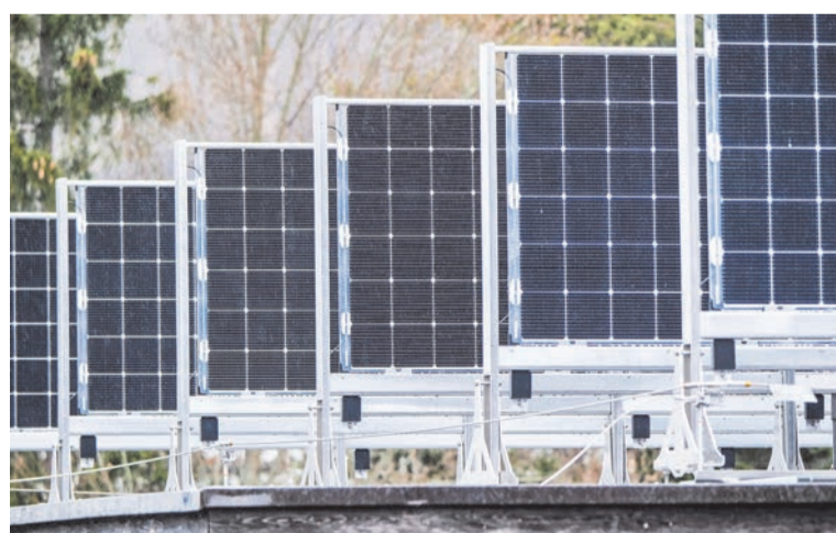
Die zweite Etappe des Green Deals umfasst 27 Massnahmen. Foto: z. VfG
