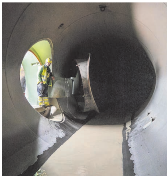
Oben und rechts: Blick ins imposante Wasserschloss Pradella. Mitte: Die Drosselklappe als Sicherheitsorgan. Unten von links: Salvatore Mammoliti auf Bain Crotsch am Eingang zum Druckstollen mit Blick in Richtung Pradella und Flurin Peretti im Druckstollen mit Blick in Richtung Ova Spin.
