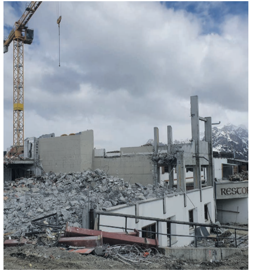
▲ Sommer Umbau Bergstation Motta Naluns.
