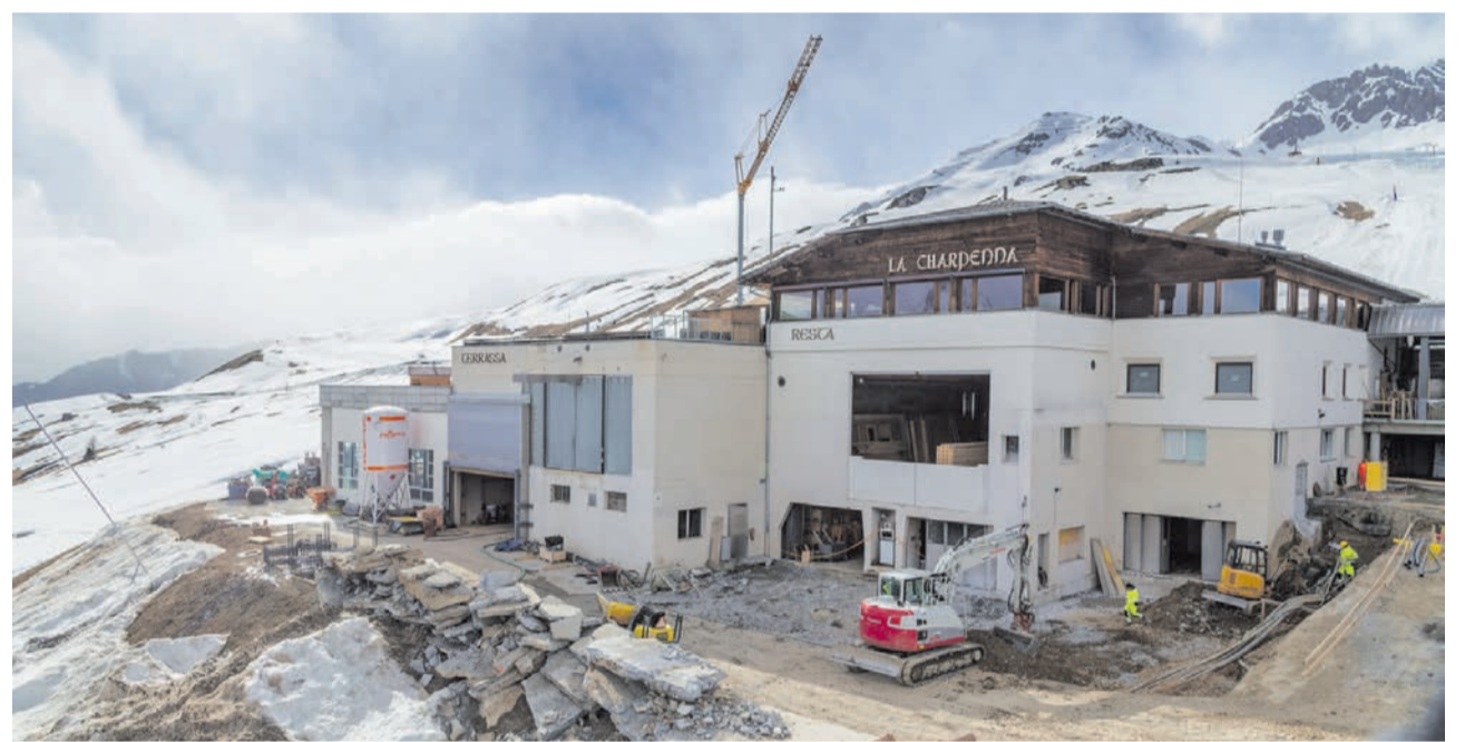
Der lange Winter 2024 hat den Beginn der Abbruch- und Umbauarbeiten erschwert. ▲
