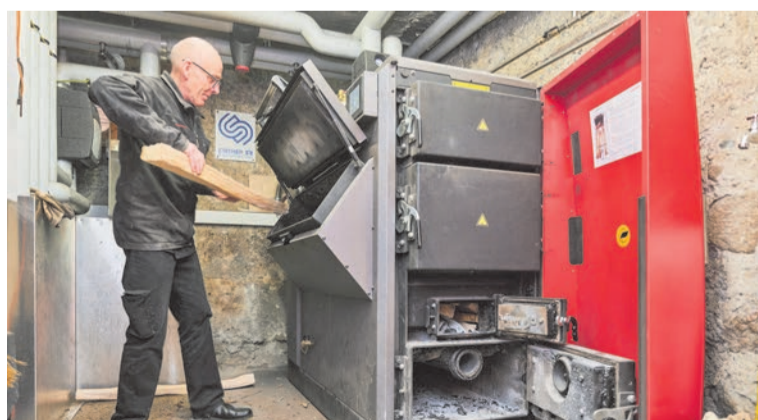
Im Gasthaus Mayor in S-charl konnte mit Unterstützung der Berghilfe bereits 2024 eine alte Holzheizung ersetzt werden.
