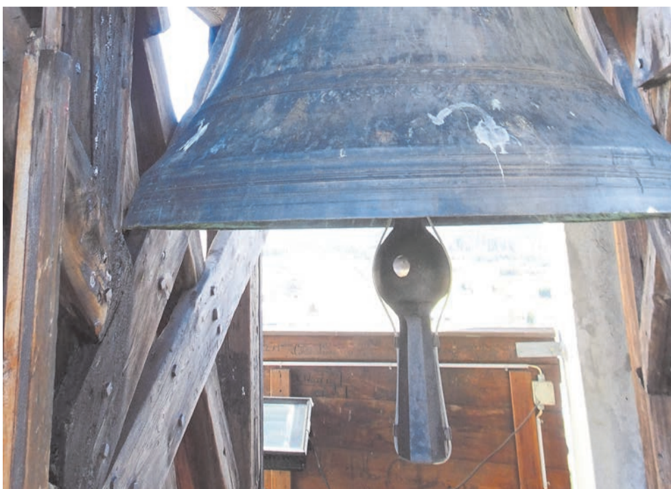
Detailansicht des Klöppels mit Aufhängung und Absturzicherung an der Samedner Kirchenglocke Nr. 2 «Mezdi».
