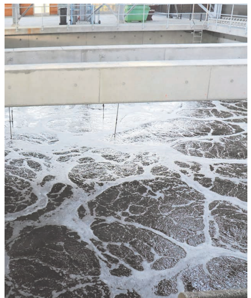
Il mainagestiu da la sarinera Engiadin'Ota, Godi Blaser, davaunt ils computers chi survaglian e manaschan l'implaunt. Ün sguard i'ls batschigls biologics, inua cha las milliardas da bacterias dischintoxikeschan il carbamit.
