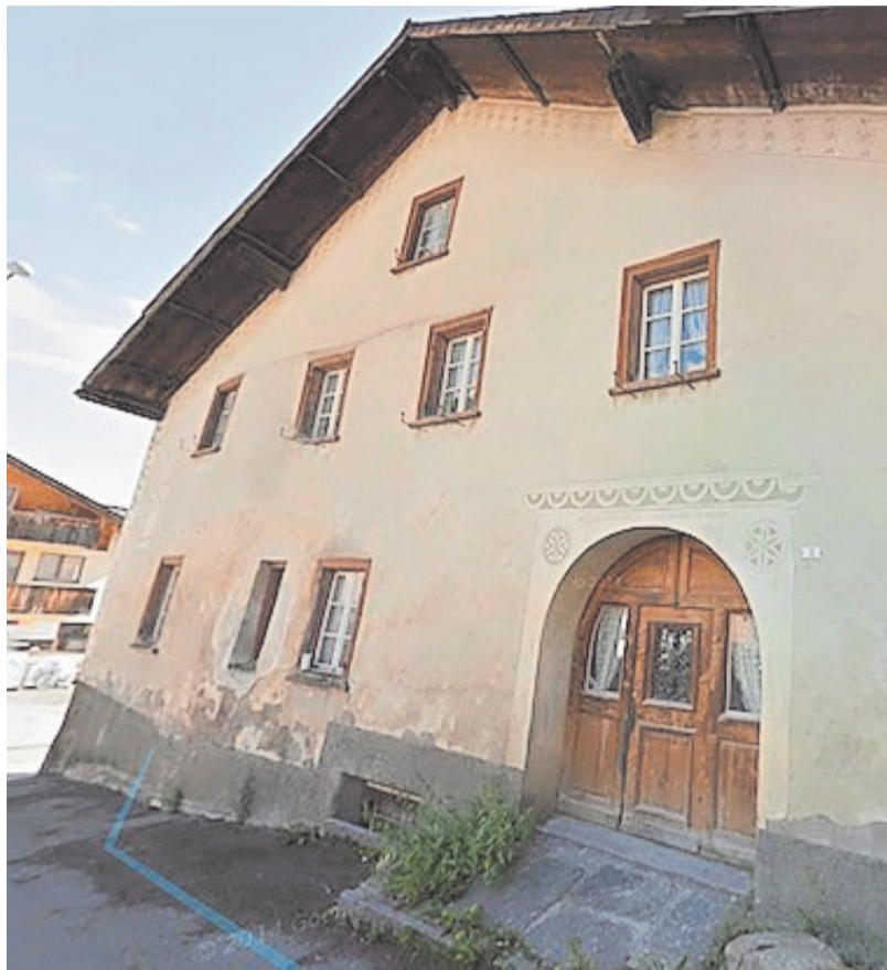
Das Vorher und Nachher eines Engadinerhauses in Sent.
