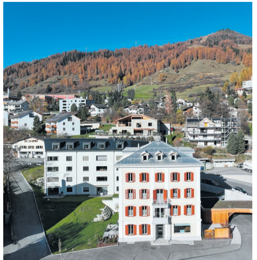
Eine erfolgreiche Zusammenarbeit: Die Bauherrschaft sowie Eiffage Suisse und die regionalen Partner sind stolz auf das Ergebnis.
