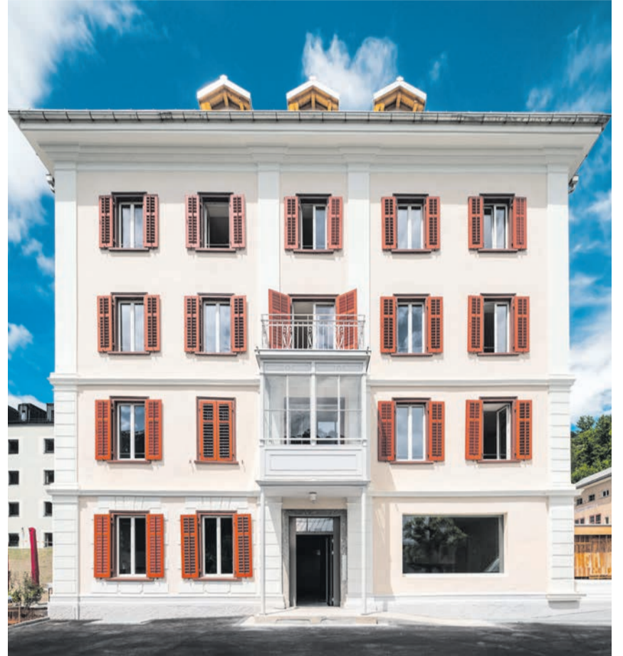
Das ehemalige Hotel «Lischana» erstrahlt in neuem Glanz.
