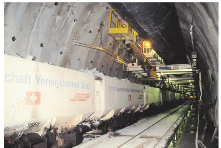
Der Durchschlag beim Vereinatunnel erfolgte am 26. März 1999. Früher und deutlich weiter nördlich als ursprünglich geplant (Bild oben). Der Spatenstich erfolgte im April 1991. Das Gestein auf der Südseite war unerwartet leicht abbaubar und ermöglichte einen schnellen Vortrieb des Tunnels. Fotos: Rhätische Bahn
