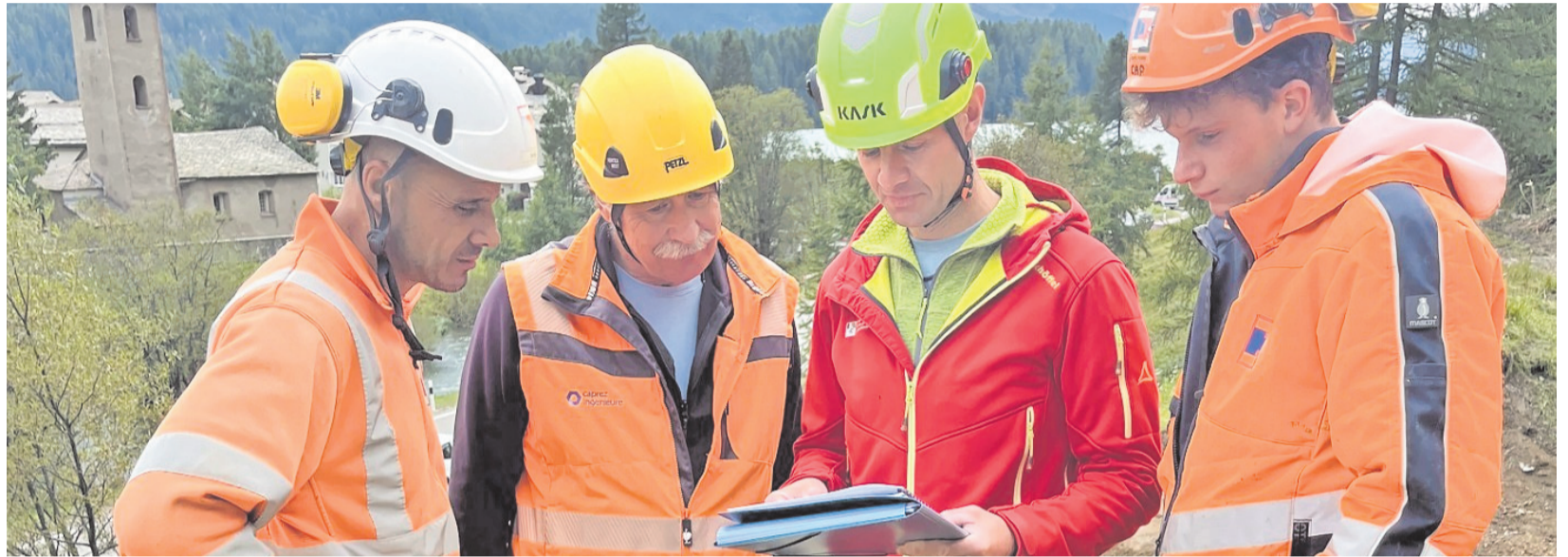
Oben: Vorarbeiten für die spätere Zufahrtsstrasse. Die Baustrasse im Hintergrund dient später als Auffangbecken. Unten: Projektleiter Jon Andri Bisaz (2. von links) und Gian Cla Feuerstein (3. von links) diskutieren mit Baufachleuten die nächsten Schritte.
