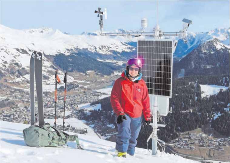
SLF-Forscherin Pia Ruttner-Jansen besucht ihre Messstation oberhalb von Davos für Wartungsarbeiten. Foto: Roman Oester/SLF
