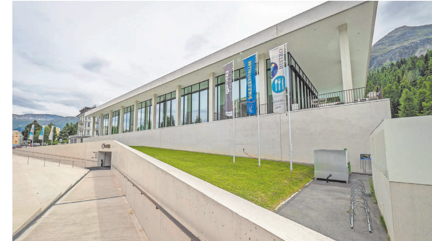
Das Ovaverva bleibt vom kommenden April bis ins Frühjahr 2026 wegen Sanierungsarbeiten geschlossen.
