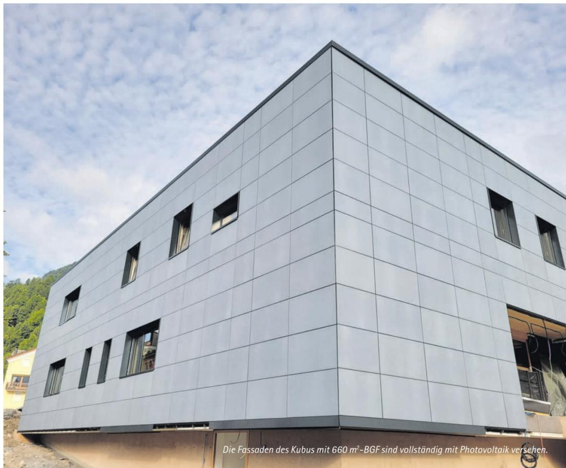
Die Fassaden des Kubus mit 660 m<sup>2</sup>-BGF sind vollständig mit Photovoltaik versehen.
