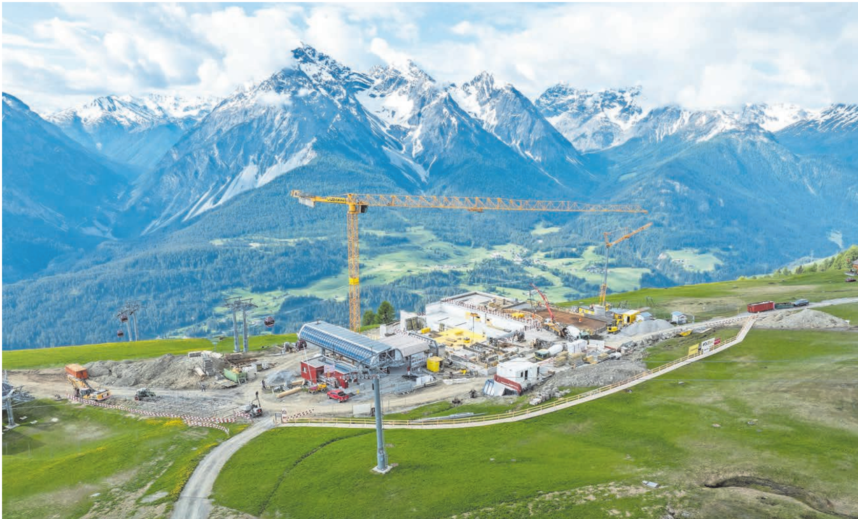
Die Bergbahn Scuol AG investiert 20 Millionen Franken in die Gesamtsanierung. Bei der Bergstation entsteht auch ein Veranstaltungsraum für rund 400 Personen.
