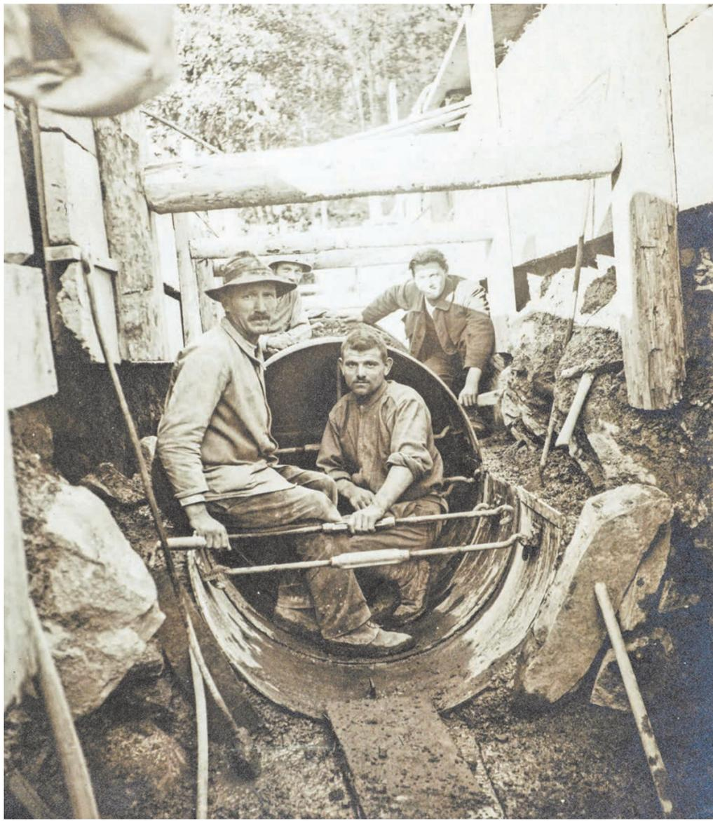
Historische Aufnahme mit Bauarbeitern beim Betonieren der Zentralrohrleitung für die Repower-Zentrale in Küblis im Jahr 1920. Fotos: Repower AG
