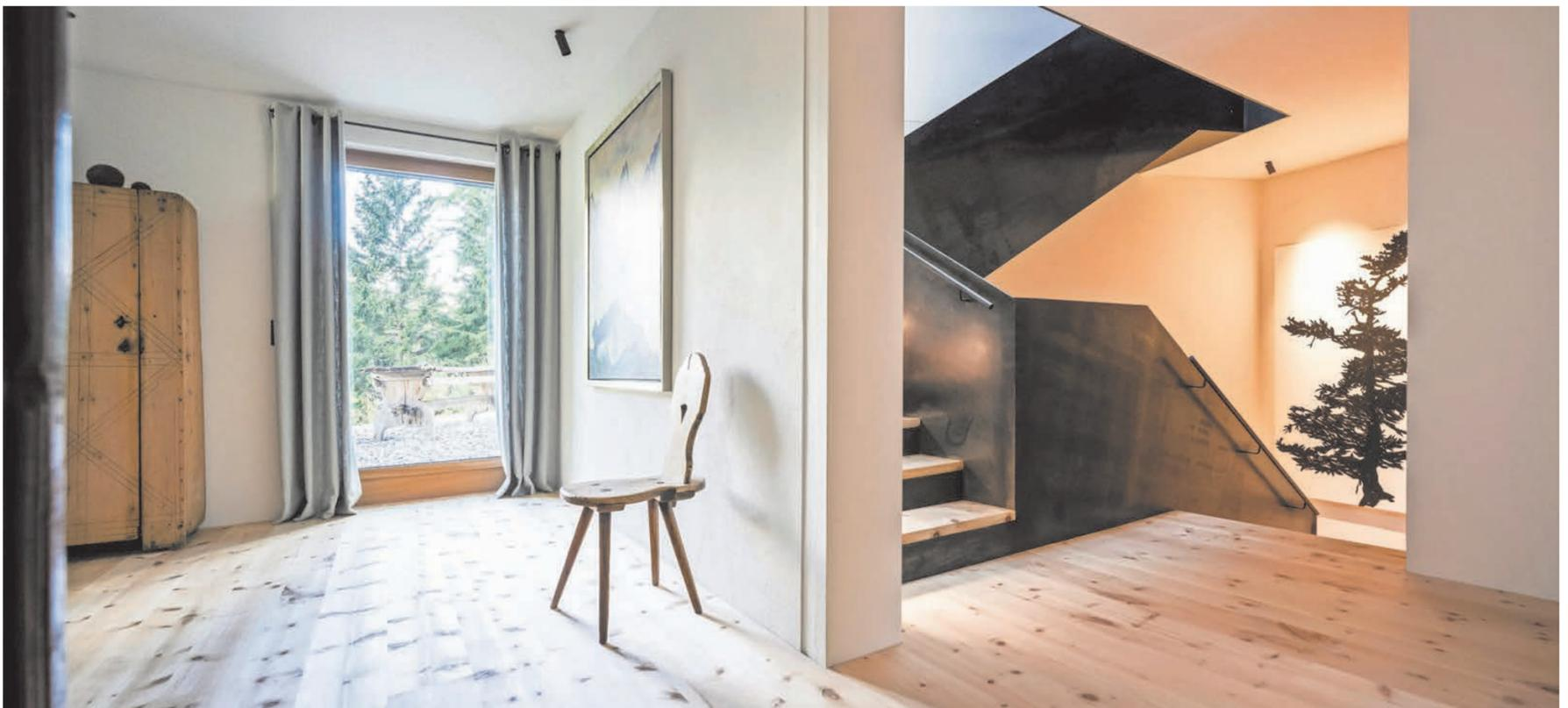
**Die Geschosse werden über eine Treppe aus unbehandeltem Schwarzstahl miteinander erschlossen. Die Böden im Haus wurden in roher Arve ausgeführt.**
