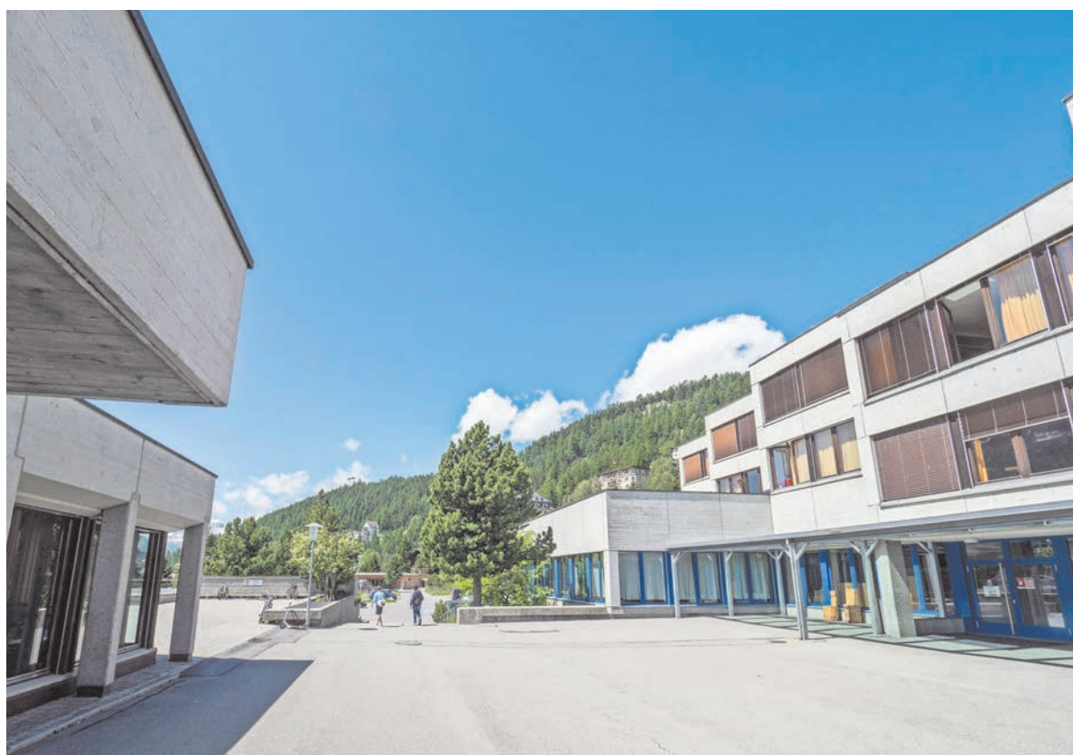
Neubau vorerst sistiert: Die Zukunft des Schulhauses Grevas in St. Moritz hängt wesentlich davon ab, ob es in Zukunft zwischen Sils und Bever nur noch eine regionale Oberstufe gibt.
