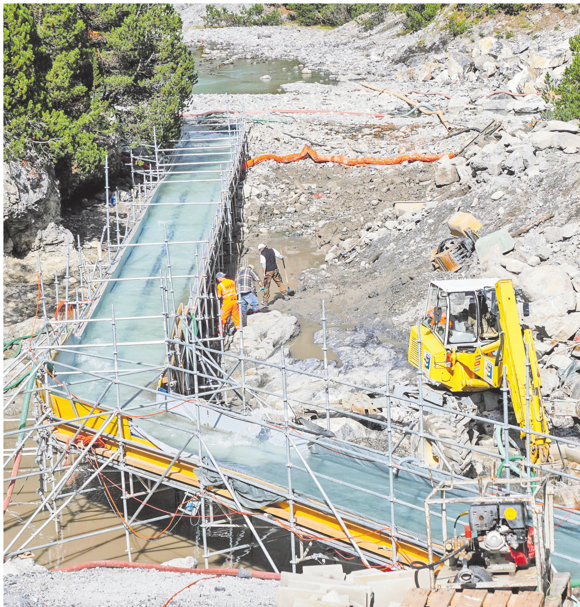
Das 60 Meter lange Tosbecken der EKW-Stauanlage Punt dal Gall bildet den Ausgangspunkt der PCB-Sanierung im Oberen Spöl. Das Tosbecken wurde schon 2017 saniert, soll aber nochmals gereinigt werden. Archivfoto: Jon Duschletta
