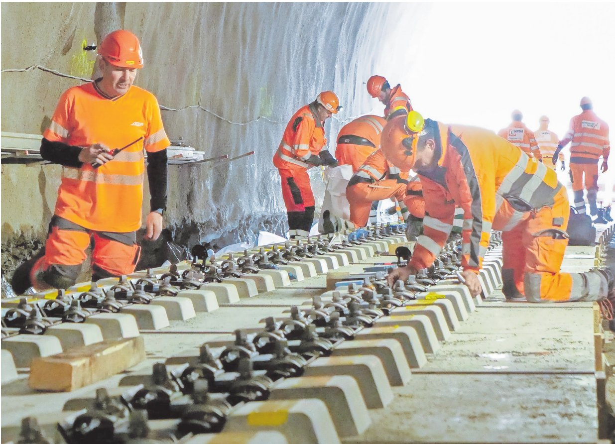
Nach der millimetergenauen Ausrichtung der einzelnen Gleistragplatten müssen Auflager und Schienenhalter exakt justiert werden. Eine Geduldsarbeit unter grossem Zeitdruck.
