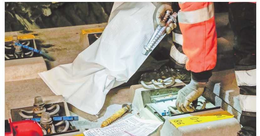
Nach der millimetergenauen Ausrichtung der einzelnen Gleistragplatten müssen Auflager und Schienenhalter exakt justiert werden. Eine Geduldsarbeit unter grossem Zeitdruck.
