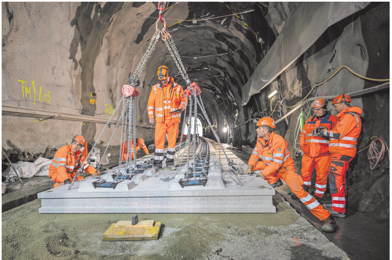
Der Aufbau der Schienenlage und der Einbau der vorgefabrizierten Gleistragplatten im Brailtunnel II war eine eigentliche Millimeterarbeit.
