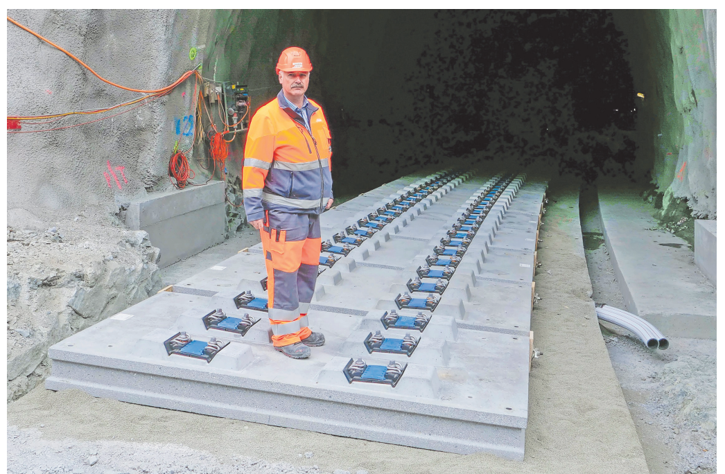
Bestand und neu: Links der alte Schienenstrang im Schotterbett und das Portal des Brailtunnels I in Richtung Cinuoschel-Brail. Rechts der Brailtunnel II in Richtung Zernez mit den neuen und innovativen Gleistragplatten, auf denen später die Schienenstränge montiert werden. RhB-Projektleiter Urs Tanner (rechts) ist mit dem bisherigen Bauverlauf sehr zufrieden.
