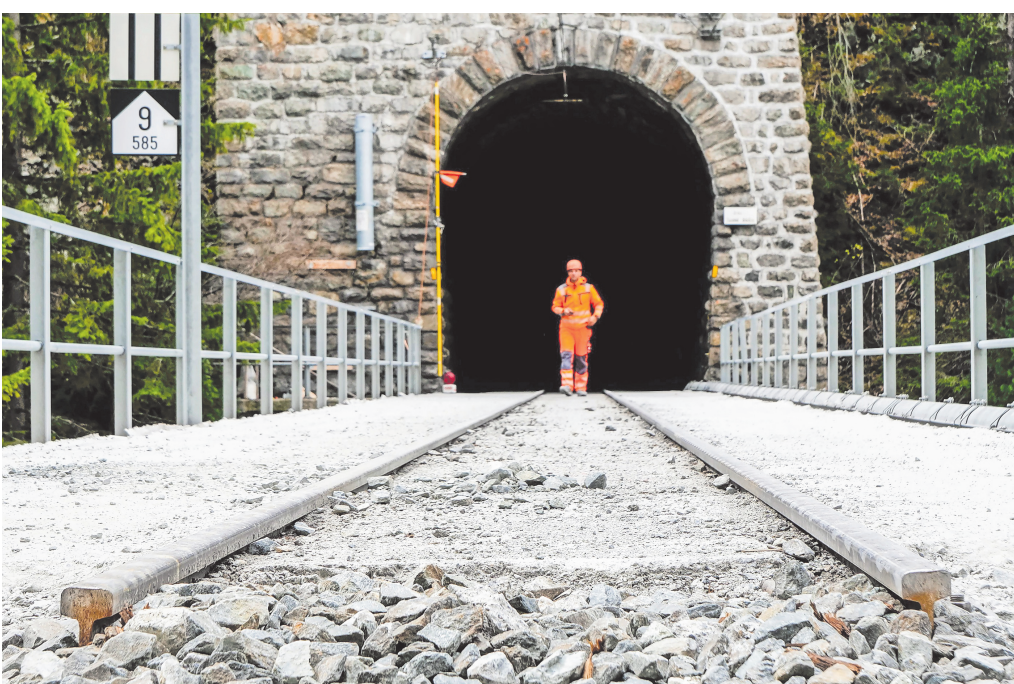
Bestand und neu: Links der alte Schienenstrang im Schotterbett und das Portal des Brailtunnels I in Richtung Cinuoschel-Brail. Rechts der Brailtunnel II in Richtung Zernez mit den neuen und innovativen Gleistragplatten, auf denen später die Schienenstränge montiert werden. RhB-Projektleiter Urs Tanner (rechts) ist mit dem bisherigen Bauverlauf sehr zufrieden.
