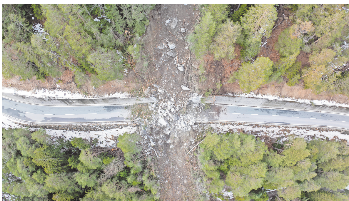
Bei Felsstürzen wie hier auf der Engadinerstrasse zwischen Martina und der Landesgrenze sind Rafael da Silva und sein Team gefordert, um die Strassen schnellstmöglich wieder freigegeben zu können.
