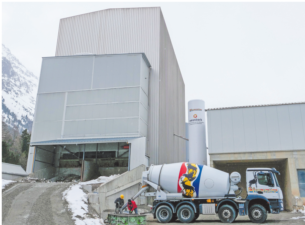
Nach der Spezialisierung auf Recyclingbeton geht das Kies- und Betonwerk Montebello in Pontresina nun einen Schritt weiter und speichert neu schädliches Klimagas CO 2 in seinem Recyclingbeton.
