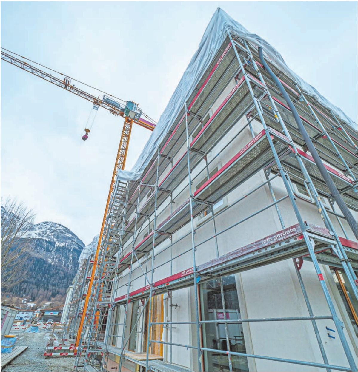
In den drei Gemeinden Samedan, Celerina und St. Moritz könnten schon bald viele neue Mietwohnungen gebaut werden.
