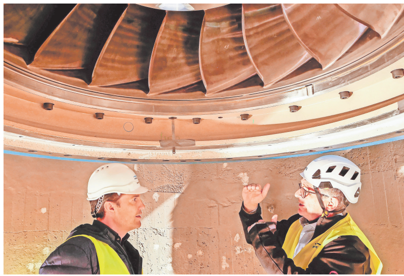
EKW-Direktor Giacom Krüger (links) im Gespräch mit Jachen Gaudenz, Leiter Betrieb und Instandhaltung, unter der 3,3 Tonnen schweren Francis-Turbine. Rechts ein Spezialist bei Montagearbeiten am oberen Turbinendeckel an einer der insgesamt vier Maschinengruppen im Kraftwerk Pradella. Fotos: Jon Duschletta
