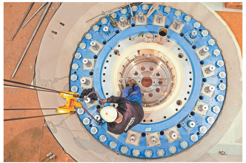
EKW-Direktor Giacom Krüger (links) im Gespräch mit Jachen Gaudenz, Leiter Betrieb und Instandhaltung, unter der 3,3 Tonnen schweren Francis-Turbine. Rechts ein Spezialist bei Montagearbeiten am oberen Turbinendeckel an einer der insgesamt vier Maschinengruppen im Kraftwerk Pradella. Fotos: Jon Duschletta
