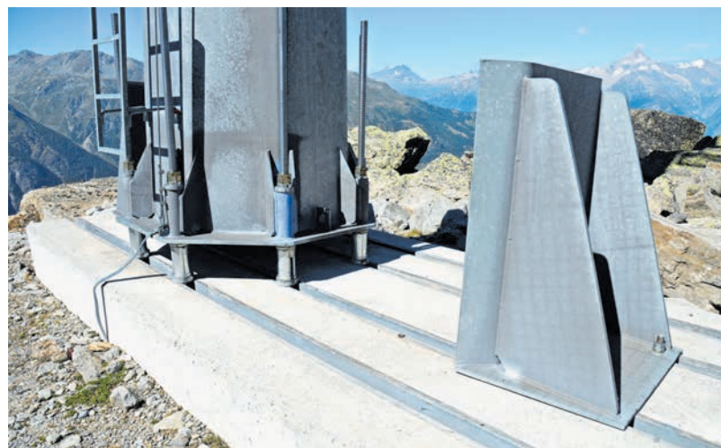
Bauen auf Permafrost am Beispiel einer schwimmend gelagerten Stütze im Gebirge (links) und Blick in ein Bohrloch mit Messinstrumenten.
