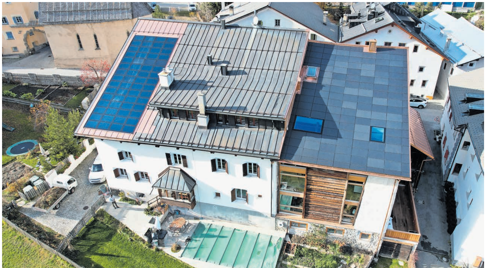
Vista our da l'ajer sül stabilimaint a Zuoz cul talvo ed il nouv implantaunt fotovoltaic a dretta e l'implaunt solar gia existant a schneistra. Il rest da l'energia bsognaiva per s-chuder las abitaziuns deriva da l'implaunt da s-chudamaint a distanza. fotografias: mad
