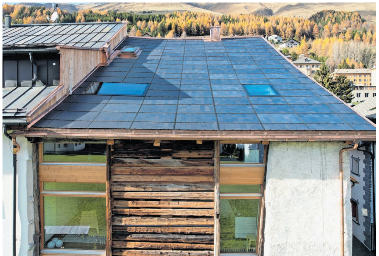
L'implaunt fotovoltaic integro illa surfatscha dal tet dal talvo reutiliso da la Chesa Schucan a Zuoz.
