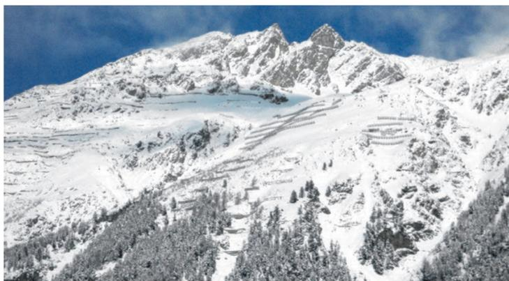
An manchen Orten werden auch Schutzeinrichtungen gegen Lawinen gebaut. Man spricht dann von Lawinenverbauungen. Dazu gehören Gestelle aus Holz oder Stahl, die man im Engadin an vielen Hängen sieht. Sie sehen aus wie grosse Zäune und sorgen dafür, dass der Schnee besseren Halt findet. So fängt er überhaupt nicht an zu rutschen und es entstehen keine Lawinen.
