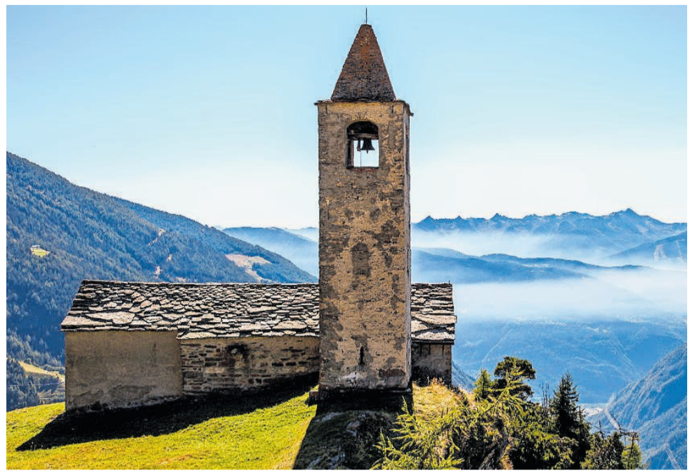
Bei der Kirche San Romero, hoch über der Valposchiavo gelegen, stehen zahlreiche weitere Restaurierungsarbeiten an.
